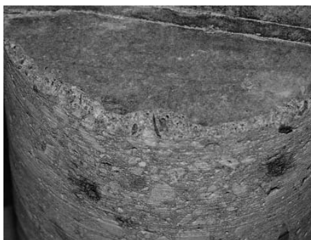
4. ábra A betonpadlóból kivett minta
