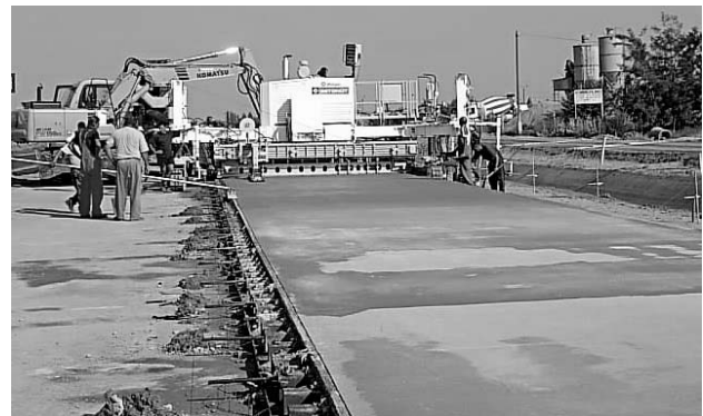
2. ábra Betonburkolat építése Békéscsaba-Gyula között (fotó: Gáspár Csongor, Betonút Rt.)
