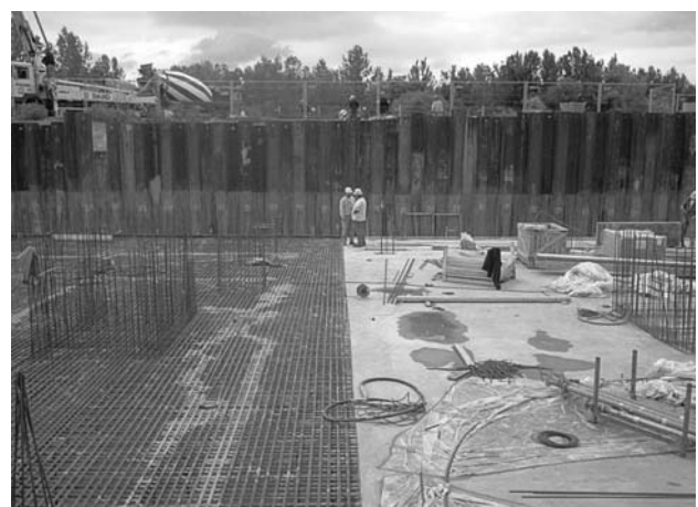
2. a-b ábra Az első ütem betonozása
