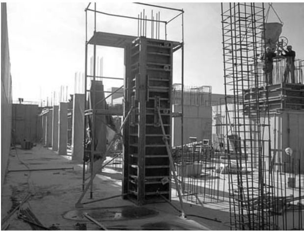
3. a-b ábra A második ütem betonozása
