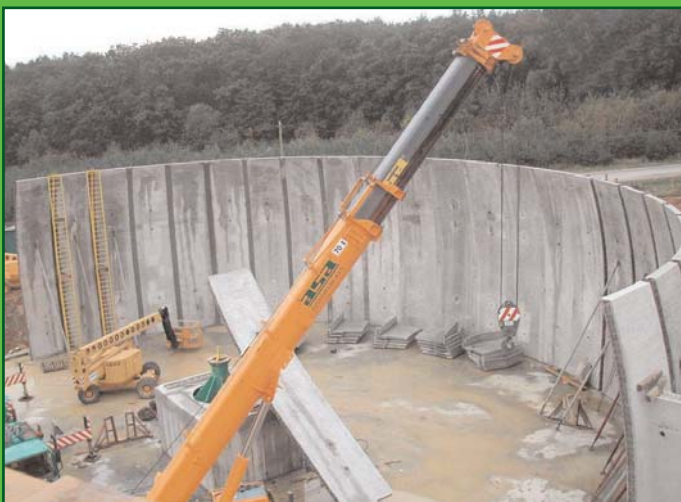
CREATON cserépgyár, Lenti agyagsziló szerelés
