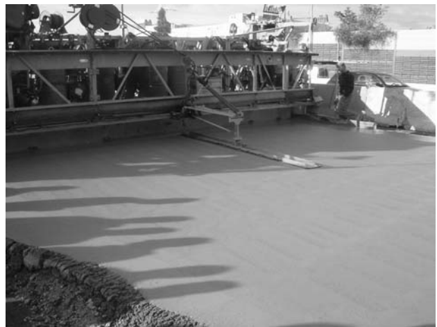
5. ábra A felhabarcosodott rétegben az LP-tartalom is megnő
