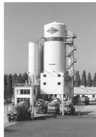
Betonüzem, Budapest Bojtár utca
