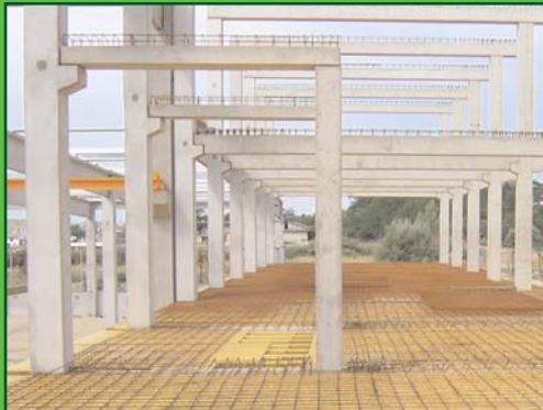
Nyílászáró üzem, Pákozd monolit közbenső födém
