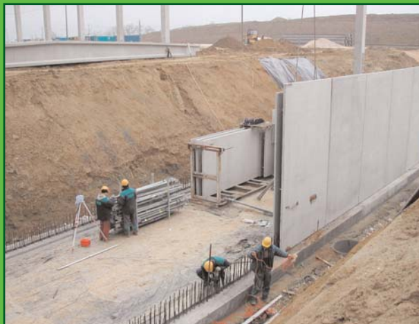
ASAHI autóalkatrész gyártó üzem, Tatabánya előregyártott akna szerelés
