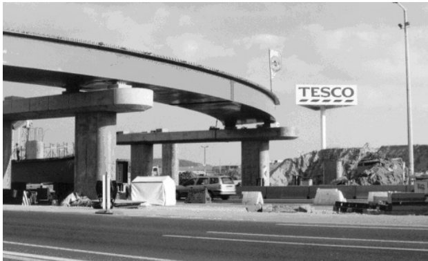
1. ábra Az M1, M7 feletti budaörsi körhíd képe építés közben [5]
