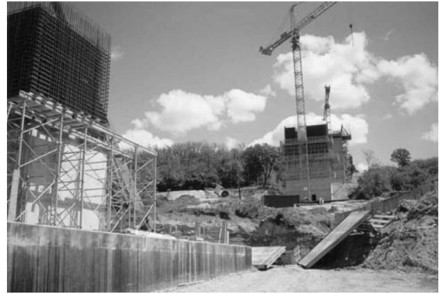
4. ábra Az M7 autópályán Kőröshegyenél épülő völgyhid képe [5]
