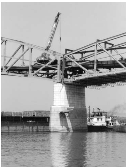
2. ábra Az esztergomi Mária Valéria-híd egyik mederpillére építés közben [5]
