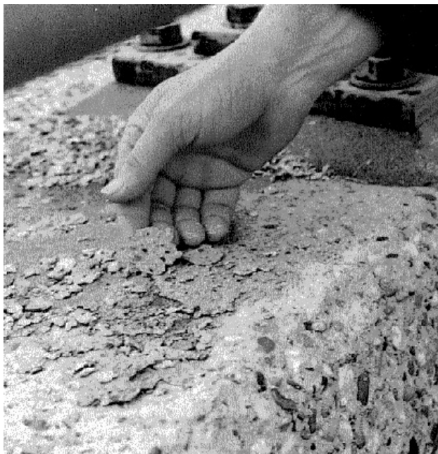
7. ábra Fagy és olvasztósó együttes hatására károsodott beton képe [6]
