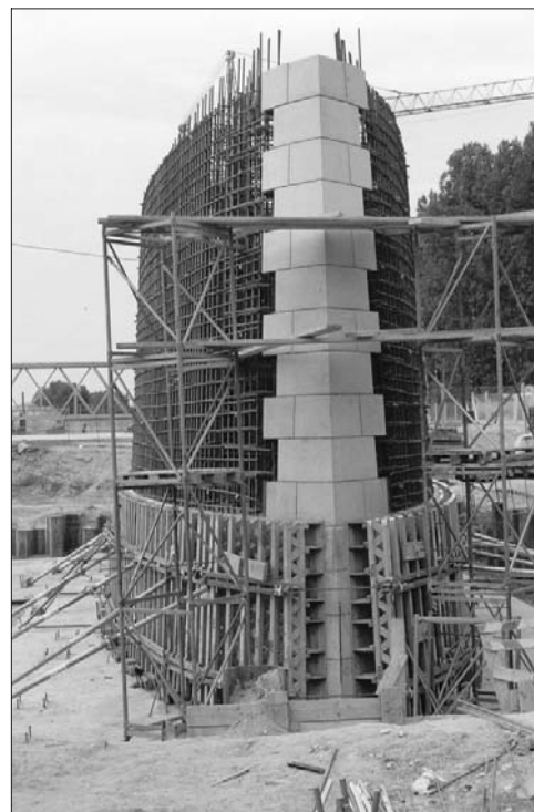
5. ábra Az épülő dunaiújvárosi Duna-híd egyik ártéri pillére betonozás előtt [5]
