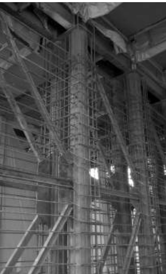
1. kép Előkészületben a vasalás
