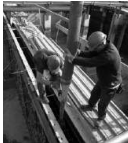
10. kép Magas fal betonozásakor ormánycsövet használnak segédeszközként
