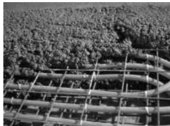
5. kép A 22 cm vastag padló betonozása
