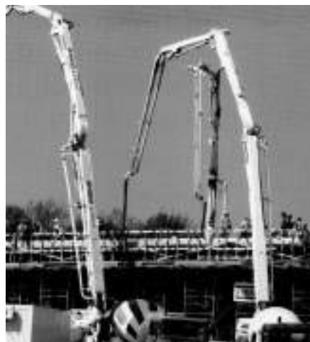
9. kép Pályalemez betonozása az M0 autópályán egyik hídján
