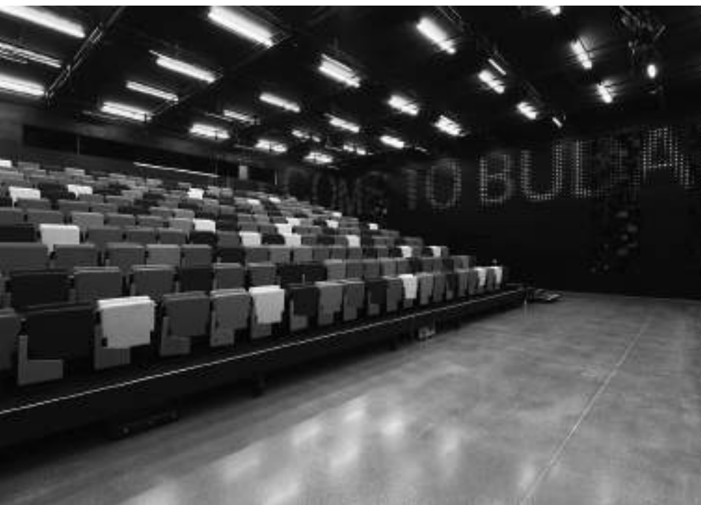
1. kép Szálerősített betonpadló a rendezvényteremben
