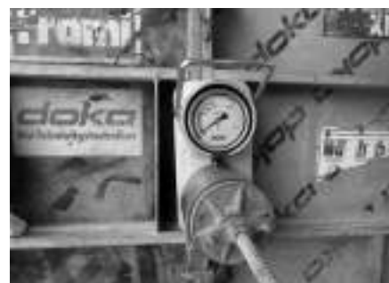
2. kép A zsaluzatot terhelő betonnyomás mérése
