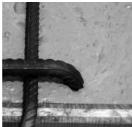
12. kép Öntömörödő beton felülete a zsálatban
