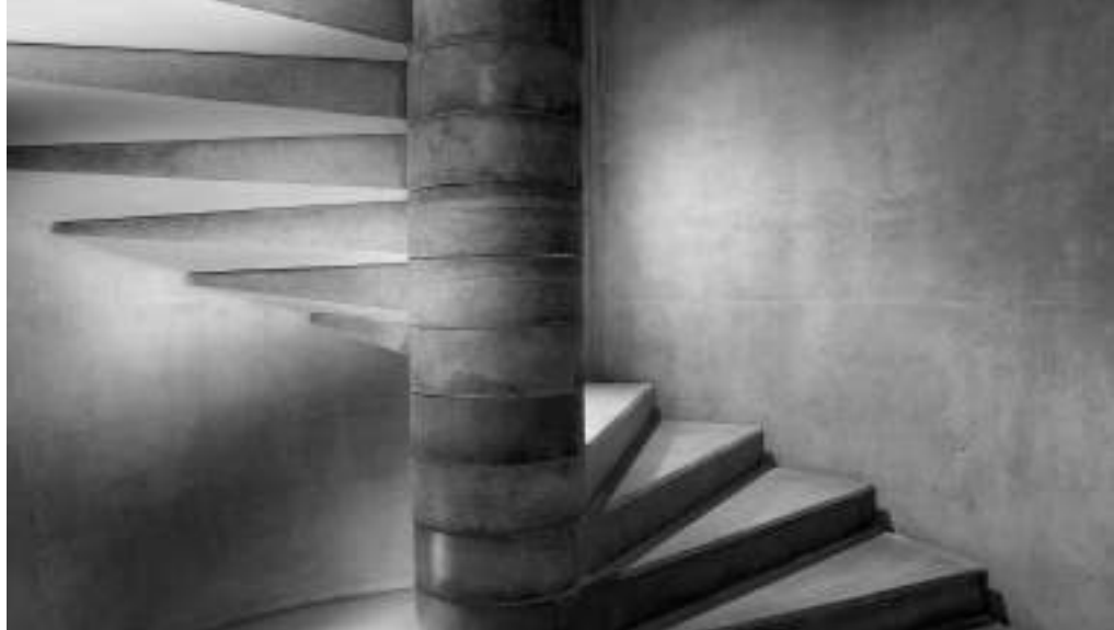
2. kép Előregyártott beton csigalépcső a várfalnál
