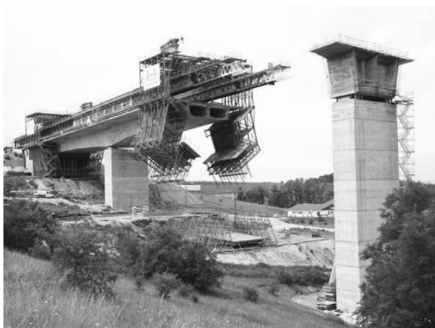
1-2. ábra Az épülő köröshegyi völgyhíd (Hídépítő Rt. felvételei)
