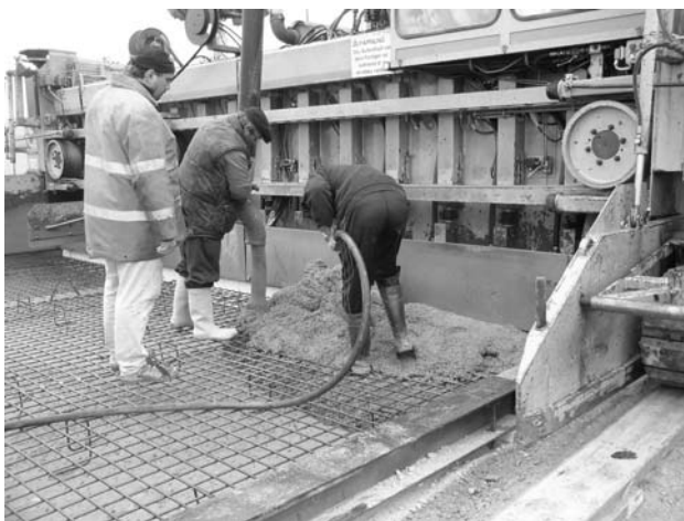
3. ábra Betonozás hídszerkezeten
