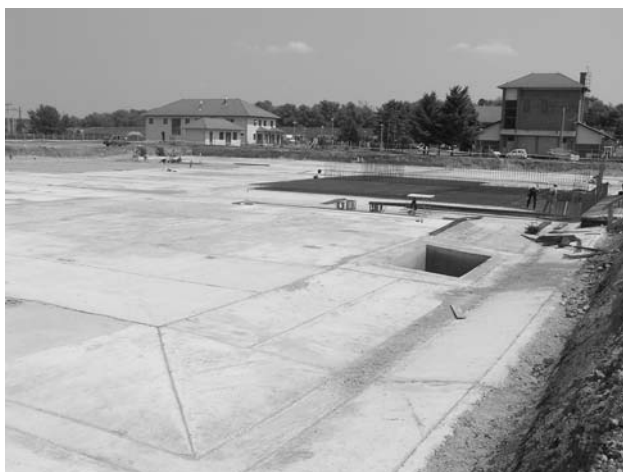
4. ábra Elkészült az alaplemez
