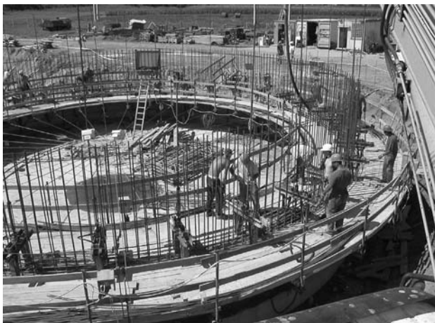
1. ábra Készül a rothasztó torony vasszerelése
