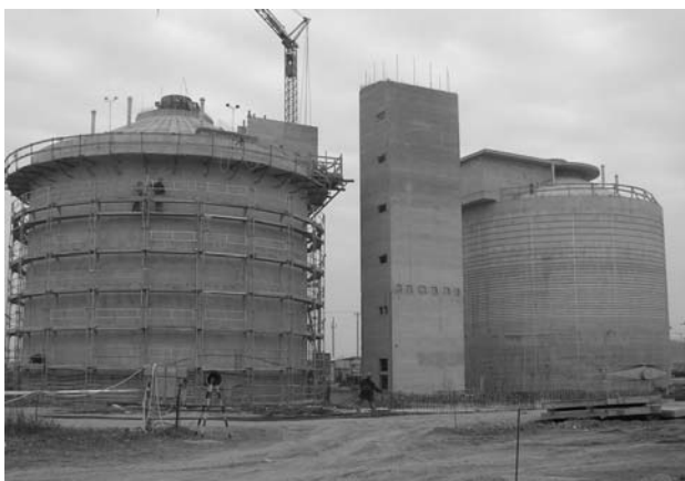
2. ábra Magasodik a két rothasztó torony
