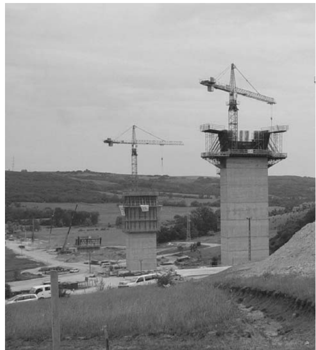
2. ábra Hidépítési alkalmazás
