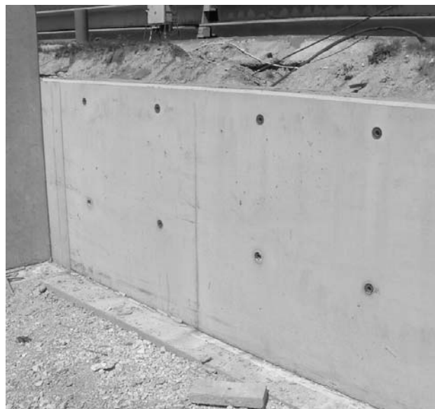
8. ábra Kiszaluzott beton felület
