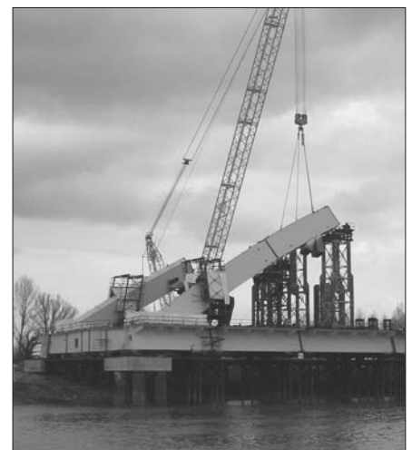
2. ábra A mederhidat egy ideiglenes állványzaton szerelik össze. Az ív-elemeket rögzítik éppen egymáshoz
