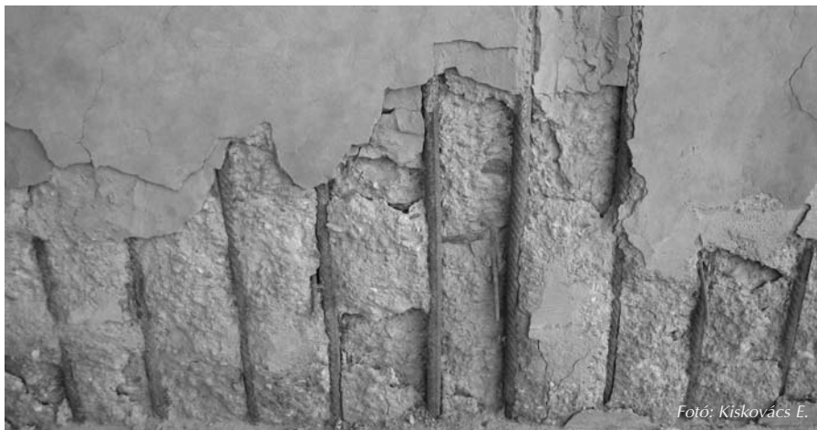
3. ábra Korrodálódott beton lábazat
