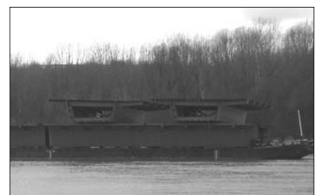
3. ábra Uszályokon várakoznak a szekrényelemek
