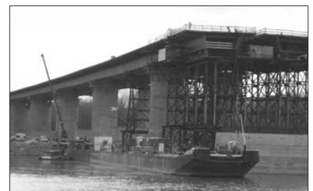
1. ábra A dunaújvárosi híd ártéri szerkezete
