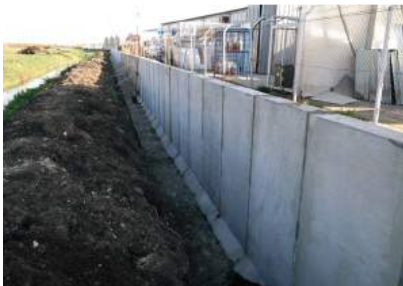
2. kép Támfalak helyszíni beépítése
