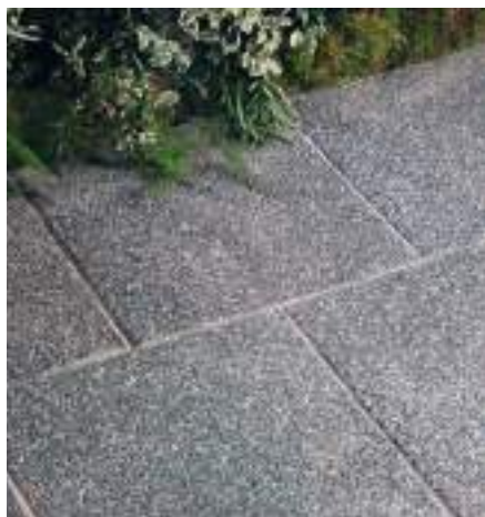
2. kép Mosott zöld murvás felületű betonlap
