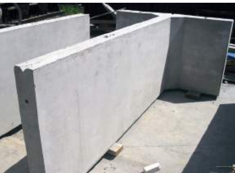
1. kép Előregyártott támfal a telephelyen
