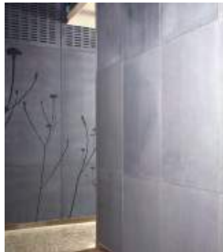
18. kép Matricás betonfelület az M4 metró, Bikás parki állomásán
