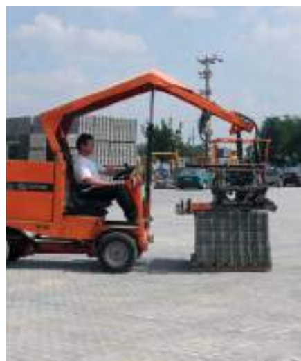
4. kép Ipari környezetben térkőrakó géppel fektetett, kitűnő kapcsolódású térkő
