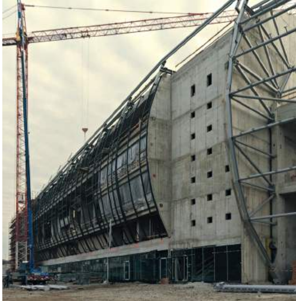
2. ábra A fejépület íves homlokzata (határoló falak íves bütüfelülettel, egymás fölé kilógó födémelek)
