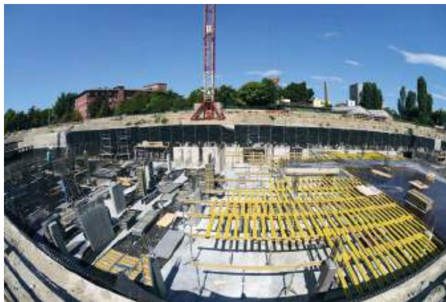
1. ábra Fejépület, mélygarázs építése
