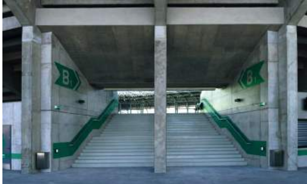
4. ábra Látszóbeton lépcsőház
