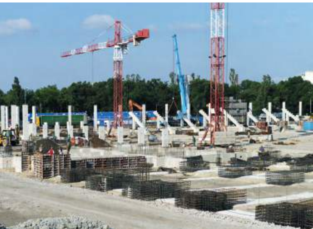
3. ábra A lelátószervezet alapozási munkái (fejtömbök és talpgerendarács építése)
