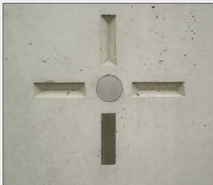
3. ábra St. Canisius templomnál ankerhelyek kiképzése (A homlokzati ornamentika Joan Walthemath new york-i képzőművész koncepciója alapján készült.)
