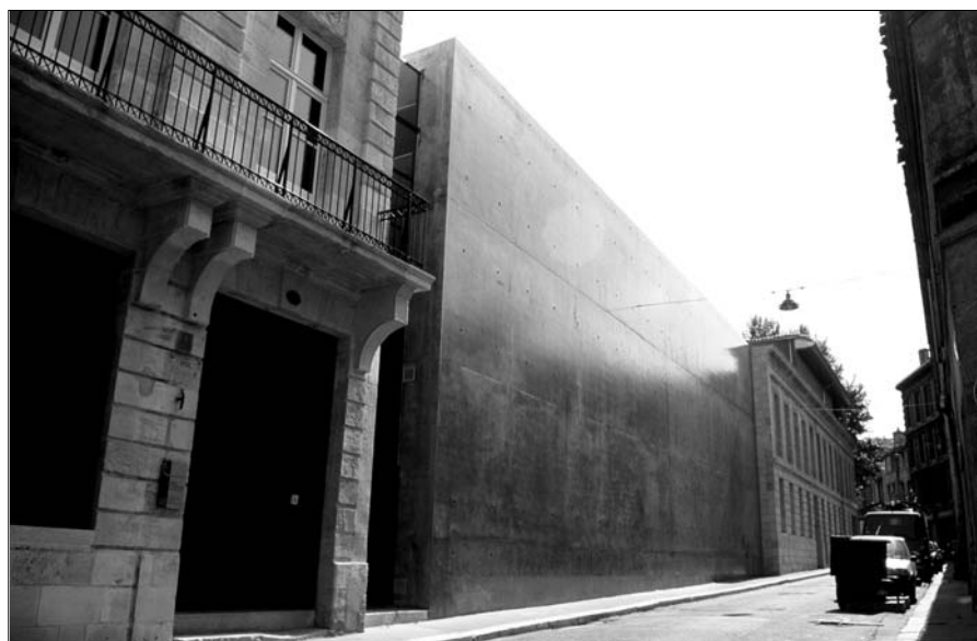
1. ábra Színbázbővítés látszóbeton homlokzata, Bordeaux
