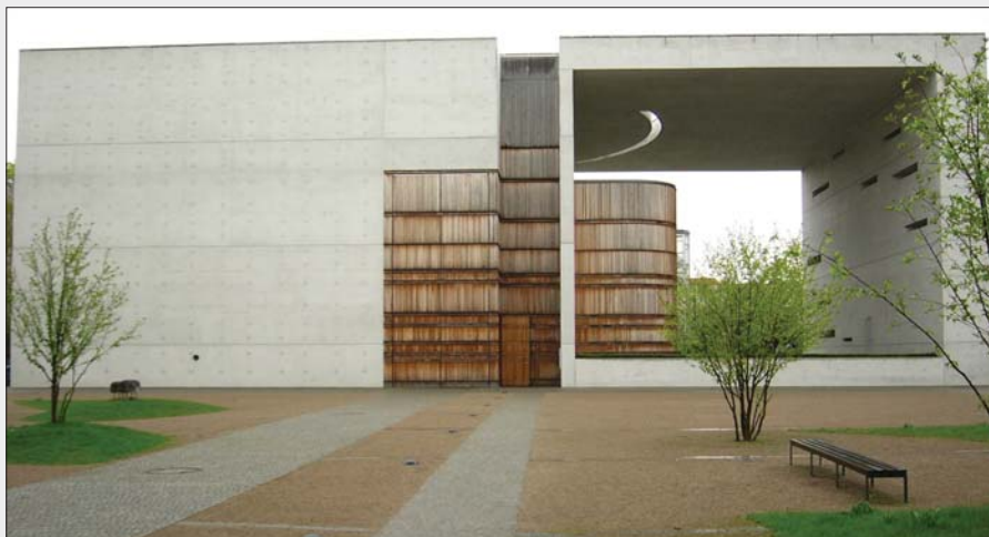
4. ábra St. Canisius templomnál belyszíni látszóbeton felületek (Berlin-Charlottenburg, építész: Büttner, Neumann & Braun)
