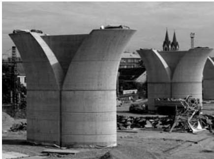
12. ábra Hídepítés - Prága
