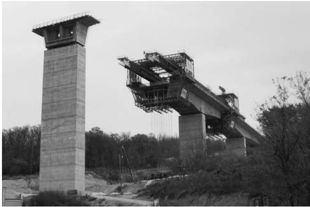
1. ábra Az épülő köröshegyi völgybíd
