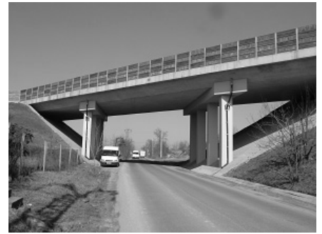
4. ábra A megerősített híd
