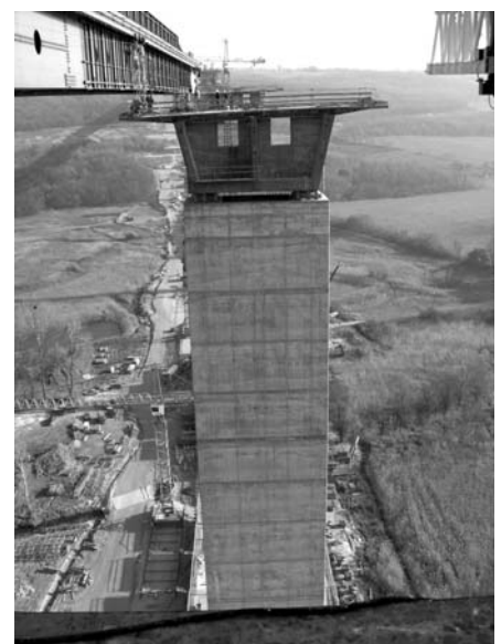
5. ábra A vezető tartók áttolása a következő pillérre
