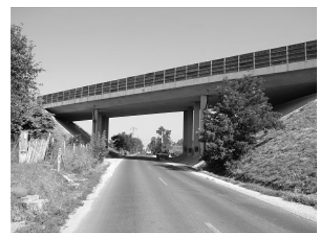
1. ábra A híd helyreállítás előtt
