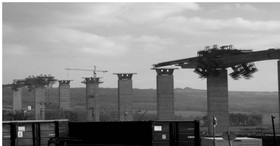
2. ábra A hídon folyó munkák
