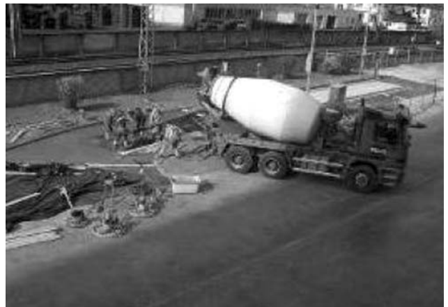
1. ábra Aszfaltburkolat felújítása vékony betonréteggel Németországban
