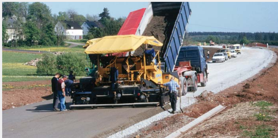
3. ábra "Hengerelt beton mint alapréteg vékony aszfaltburkolattal" kísérleti szakasz a B54 úton Westerwaldban
