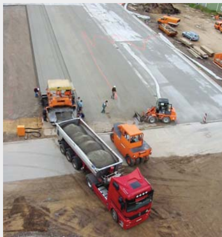
1. ábra Hengerelt beton beépítése sávokban
