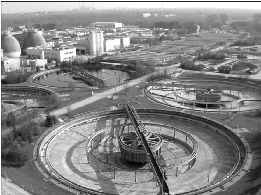
1. ábra A szennyvíztisztító telep Großlappenben
