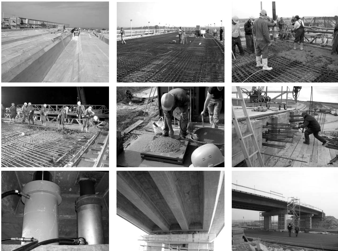
7. ábra A felszerkezet építésének mozzanatai
