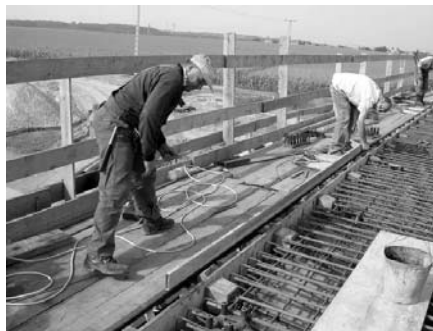
6. ábra A lehúzógerenda alátámasztása egy zsaluzaton kívül elhelyezett zárt szelvényű sínnel
