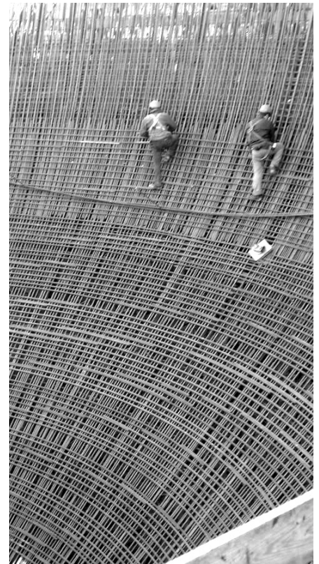
2. ábra Az iszaprothasztó tartály falának vasalati nézete
