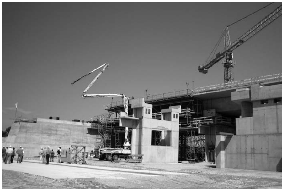
3. ábra Addig a látogatók másik fele az építkezést tekintette meg, ahol éppen a pályalemezt betonozták
