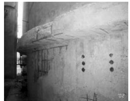
4. ábra A cellafal külső felületének károsodása
