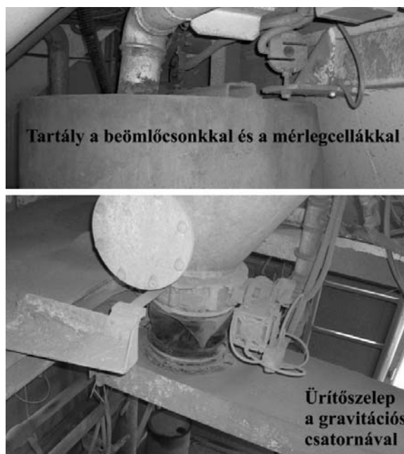
1. ábra Vízmérleg a Holcim Hungária Zrt. Kőbányai Betongyárában
