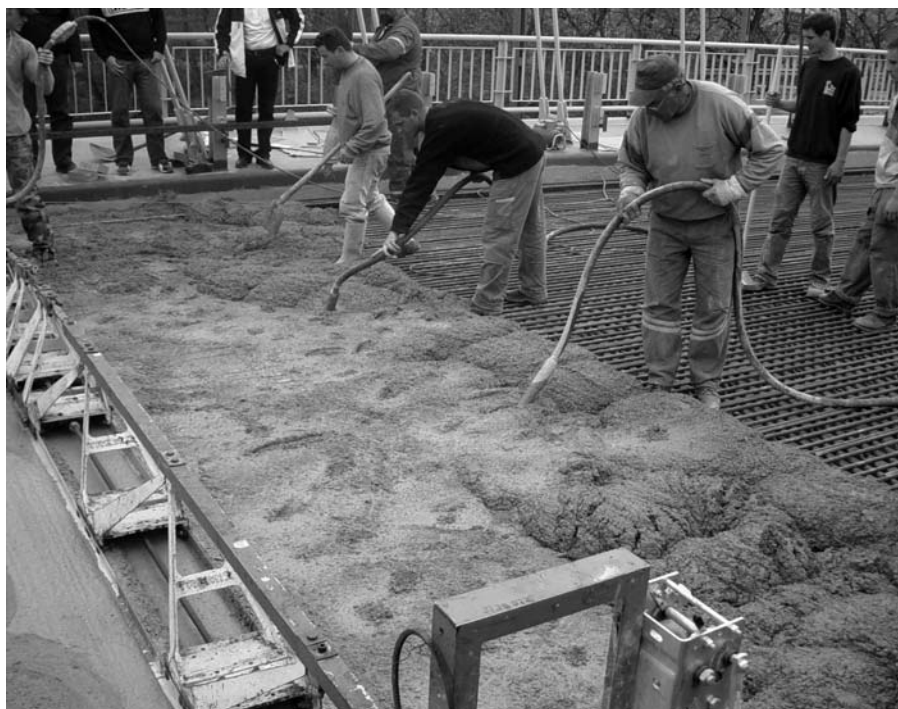
5. ábra A balatoni-úti vasúti felüljáró pályalemezének betonozása. A Mapecrete rendszerrel készült beton a mai napig nem repedt meg. A pályalemez kb. 40 mx8 mx8 cm méretű volt, és acél szerkezetre került.
