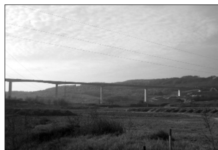
3. ábra A viadukt a völgy felől nézve
