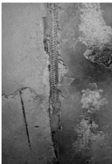
7. ábra A fenéklemez alsó felületének károsodása
