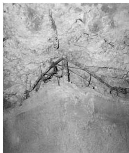
11. ábra Kivitelezésből származó hiányosságok az oszlop és az oszlopfő találkozásánál
