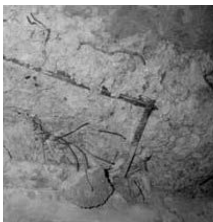
6. ábra Az ürítőnyílású vasbeton tölcser jellegzetes repedése
