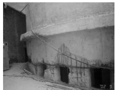
5. ábra A betontakarás leválása a siló lábzatának külső felületén
