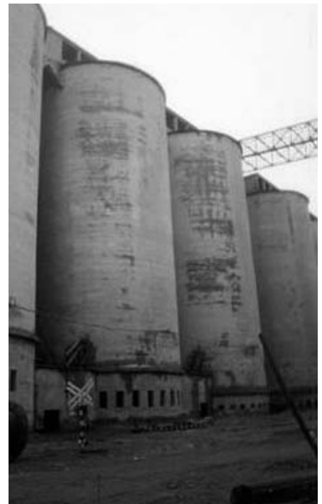
4. ábra A cellafal külső felületének károsodása
