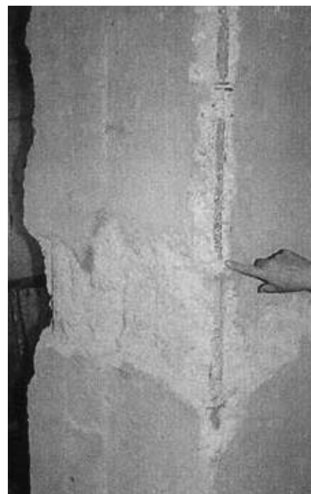
10. ábra A tartóoszlop hiányos keresztvasalása
