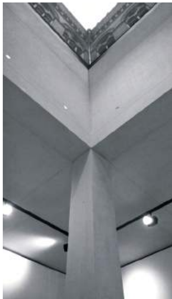
4. kép Látszóbeton szerkezeti csatlakozások (oszlop, födém, attikafal)
