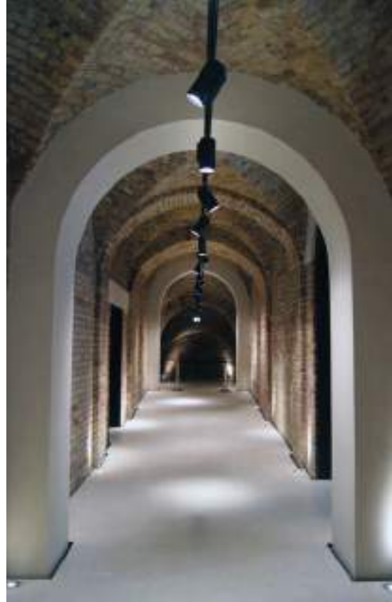
2. kép Monolit látszó kéregbeton
