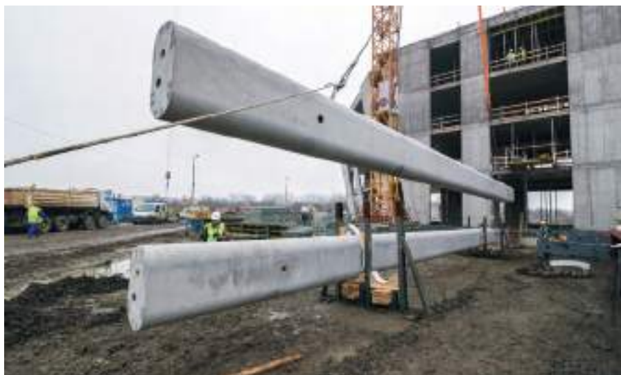
3. kép Pillérek letárolása az építési területen
