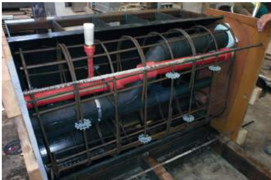
2. kép A gépészeti vezetékek elhelyezése
