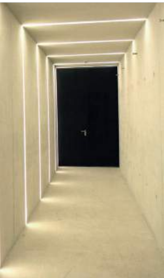
1. kép Látszóbeton átközlekedő alagút a bebetonozott világítótestekkel
