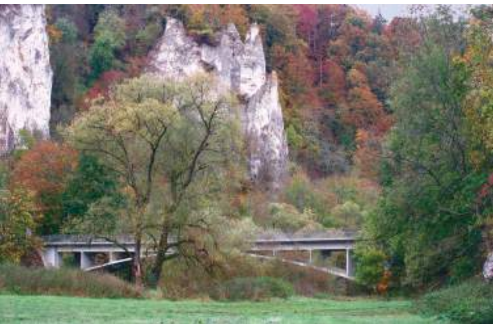
1. kép Nickhof, közúti híd a Fekete-erdőben
