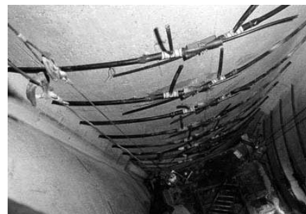
18. ábra Példa silócellák feszítéssel történő megerősítésére
