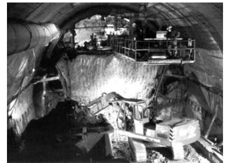
3. ábra A Gotthard közúti alagút építése
