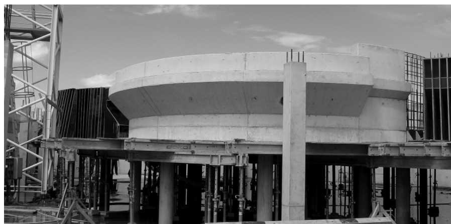
3. ábra Íves szerkezet kizsaluzás után
