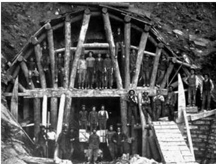
2. ábra Az első Gotthard vasúti alagút építése
