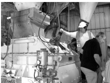
12. ábra A betonkeverő működés közben. Az elkészült betont mobil vasúti mixerrel szállítják a több mint 20 km-re lévő felhasználási helyre
