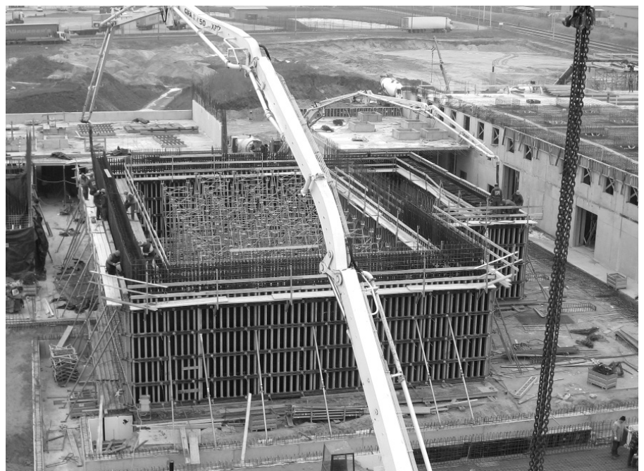
1. ábra A bezsaluzott falakat egyszerre két helyről betonozzák
