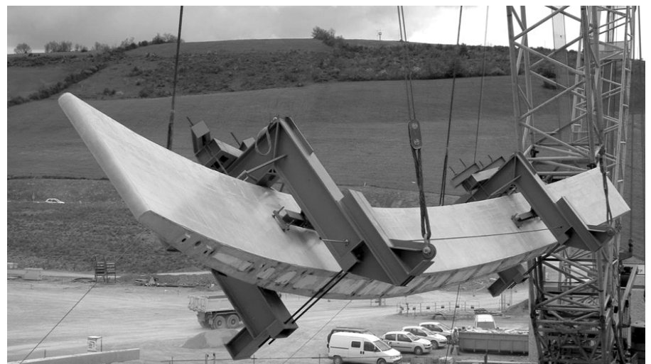
2. ábra Légyártott tetőelem
