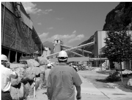
11. ábra Útban a betonüzem felé. Balra látható a kőzetosztályozó
