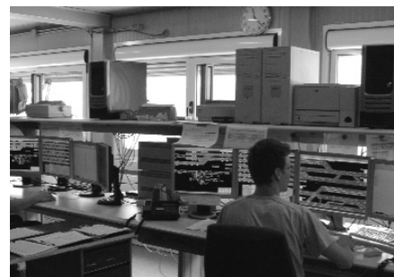
15. ábra Ez az irányító központ ellenőrzi az egész folyamatot, a betonüzemi gyártást is beleértve
