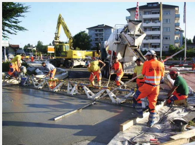
3. ábra Kivitelezés kézi beépítéssel
