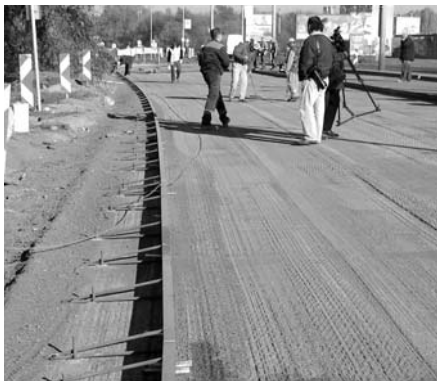
2. ábra Így nézett ki az előkészített útfelület, a lemart aszfaltburkolat
