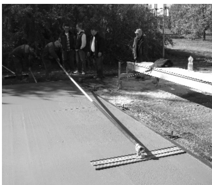
5. ábra A friss betonon alumínium tolóléc végigtolásával a felületi egyenetlenségeket javítják
