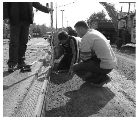
1. ábra Műszerrel állítják be a magasságát az L-acél oldalzaluzatnak
