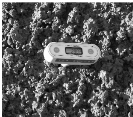
9. ábra A kivitelezés során a beton hőmérséklete folyamatos ellenőrzés alatt áll
