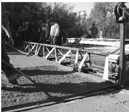
4. ábra A betont vibrogerendával tömörítik
