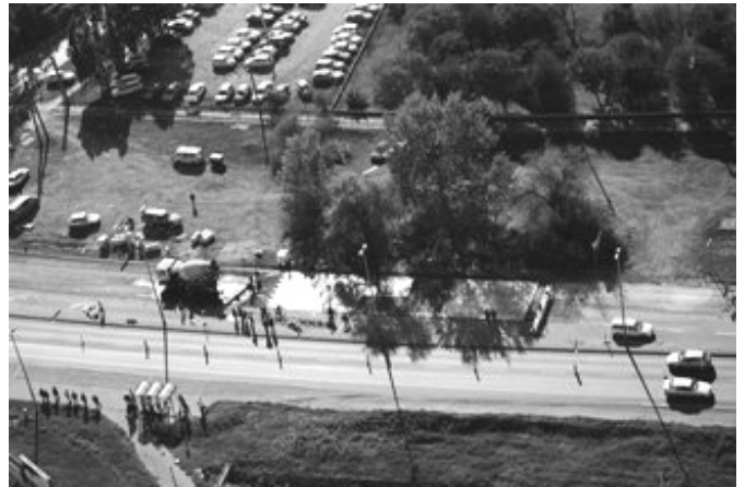
4. ábra Munka közben
