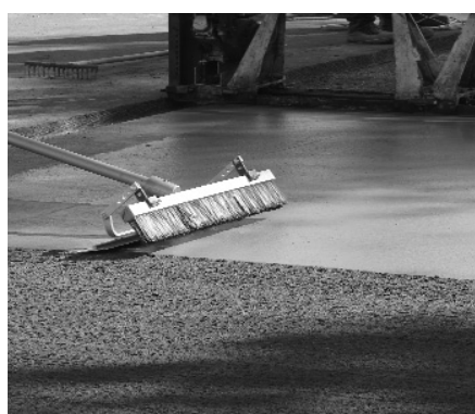
7. ábra A beton felületének érdesítése seprűzzel történik
