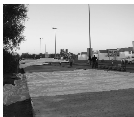
11. ábra Az éjszakai hideg miatt hőszigetelő lemezzel terítik be este az útburkolatot
