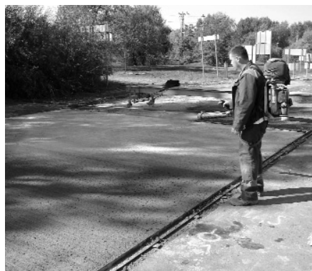
8. ábra A frissen elkészült burkolatra utókezelésként párazárószert permeteznek ki
