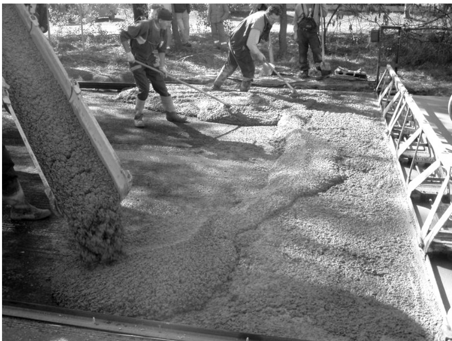
5. ábra A beton bedolgozása
