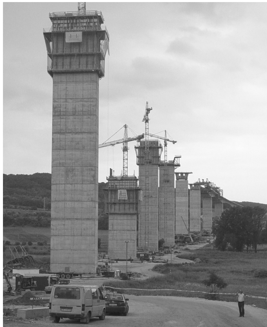
3. ábra A Köröshegyi völgyhíd pillérei az M7 autópályán Zamárdi-Balatonszárszó szakaszán
