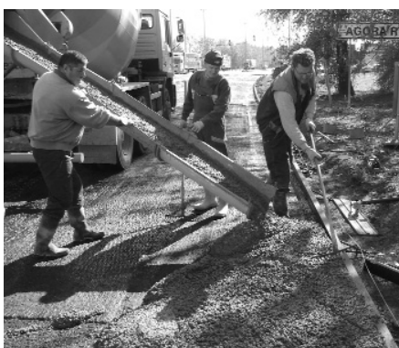
3. ábra A mixerkocsiból kiöntött betont kézi erővel egyengetik széjjel
