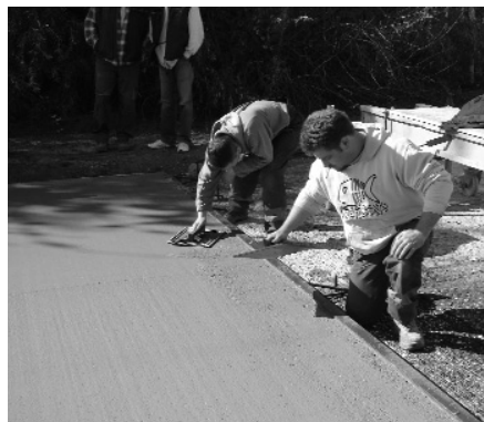
6. ábra A kisebb egyenetlenségeket az U acél lezáró zsaluzat mellett kézzel simítják el
