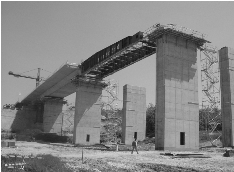
4. ábra Az S16 jelű híd az M7 autópálya Balatonszárszó-Ordacsebi szakaszán
