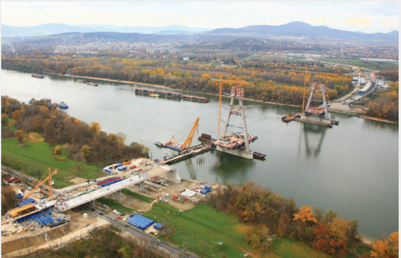
3. ábra Előtérben látható a bal parti (pesti oldali) ártéri híd, aztán a nagy Duna-ág hídja a magasodó pilonokkal, majd a Szentendrei-sziget fölötti ártéri híd, a szentendrei Duna-ág hídja és a jobb parti ártéri híd
