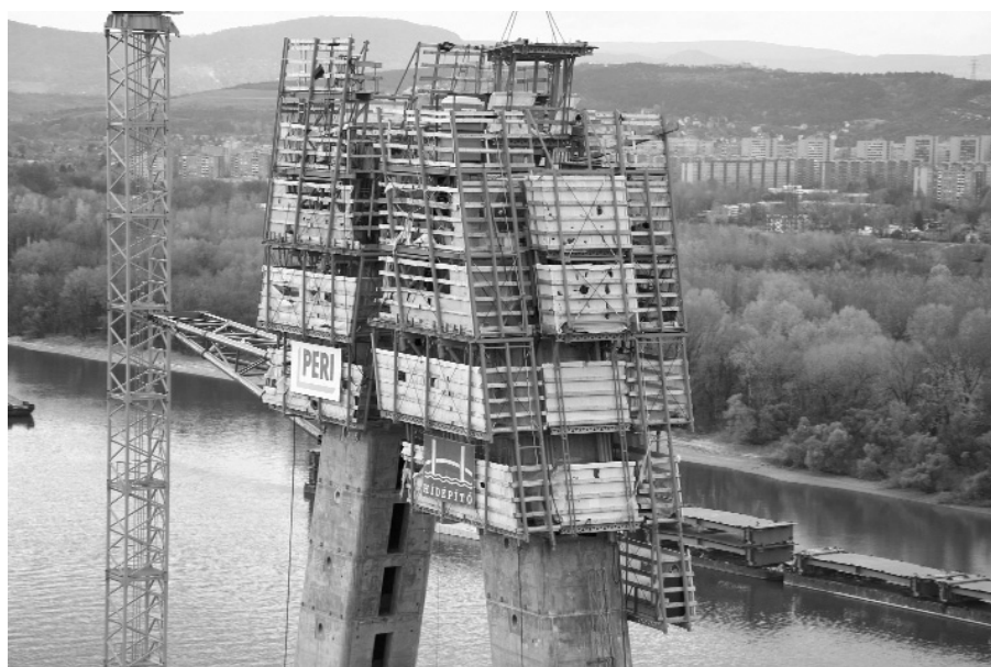
1. ábra A 7. számú pilon a zsályuzattal
