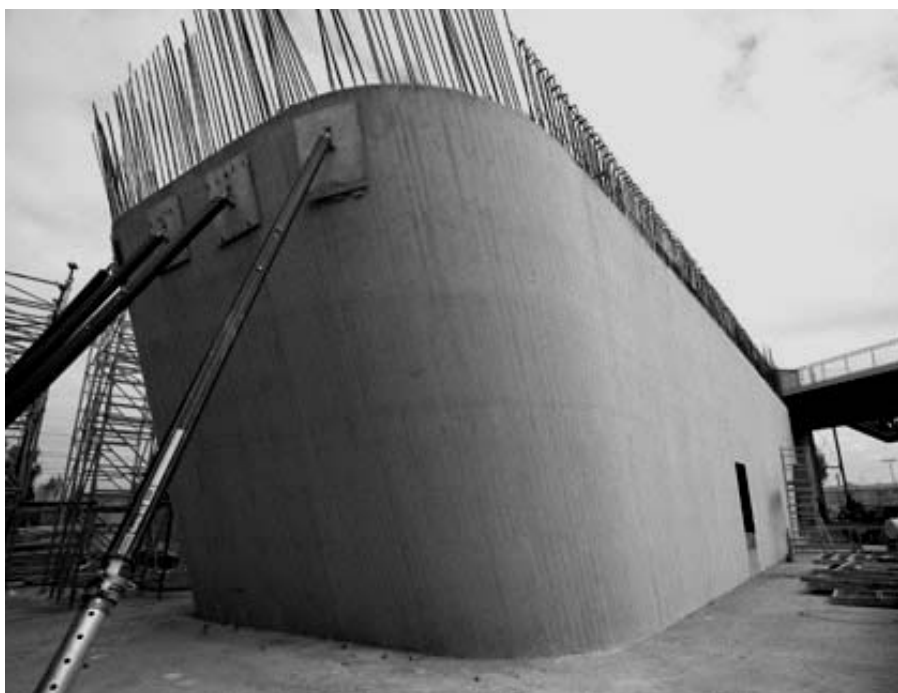
1. ábra Egy íves látszóbeton felület
