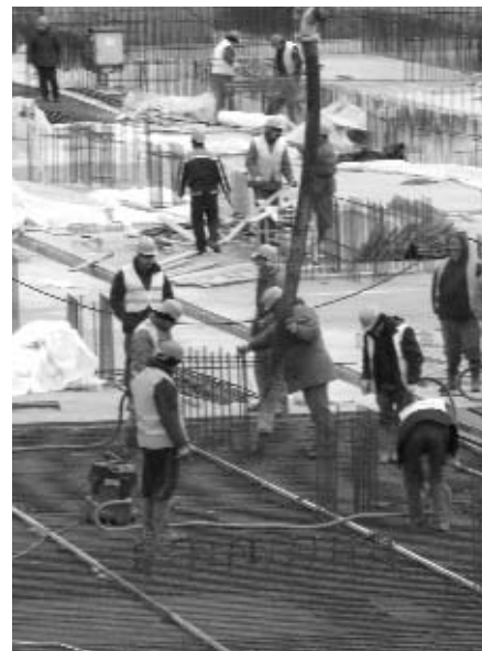
3. ábra Az alaplemez betonozása
