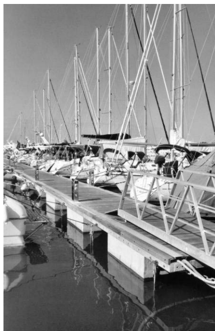
3. ábra Úszó, álló kikötői szerkezet Novigradban (Horvátország)
