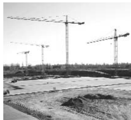
2. ábra Elkészült a szerelőbeton
