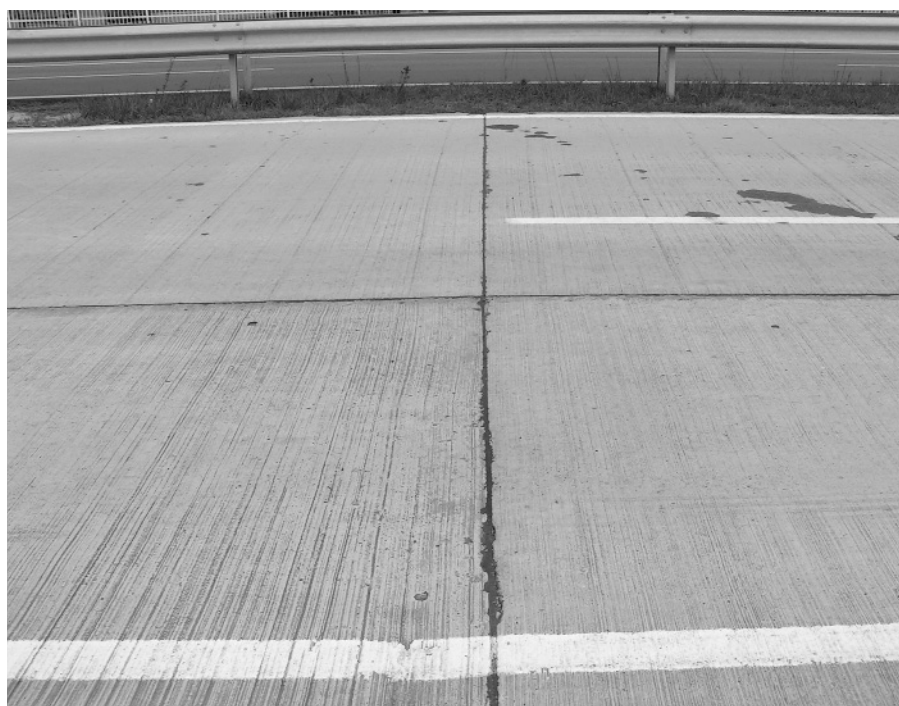
6. ábra Betonburkolatú szakasz különböző érdességű felületei
