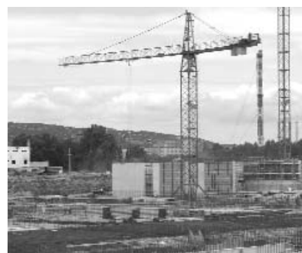
5. ábra Munkálatok a földémszinten
