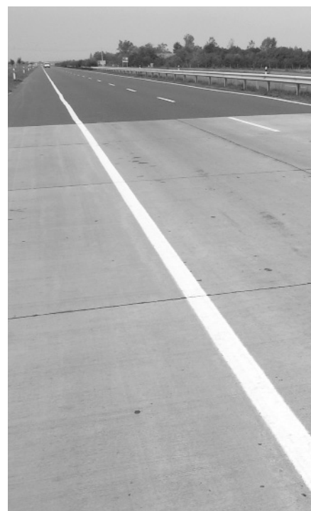
7. ábra A kísérleti szakasz merev és kompozit pályaszerkezet csatlakozási képe. A merev pályaszerkezet kopórétege beton, a kompozit pályaszerkezeté aszfalt
