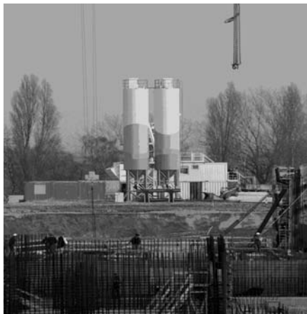
6. ábra A belyszíni betonüzem és labor (KABAG-Wiggert DWM 4500, 100 m 3 /h)
