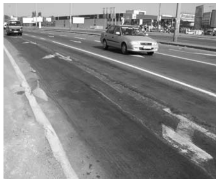
5. ábra A kísérleti szakasz helyszíne a felújítás előtt
