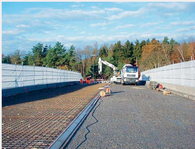
1. ábra A lemart, előkészített felület
