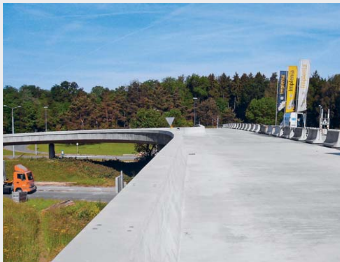
2. ábra Az új betonburkolat és az előtétbeton szegély
