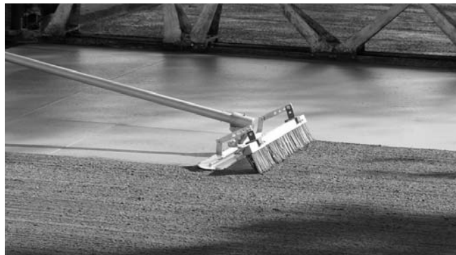
8. ábra Burkolat felület érdesítése
