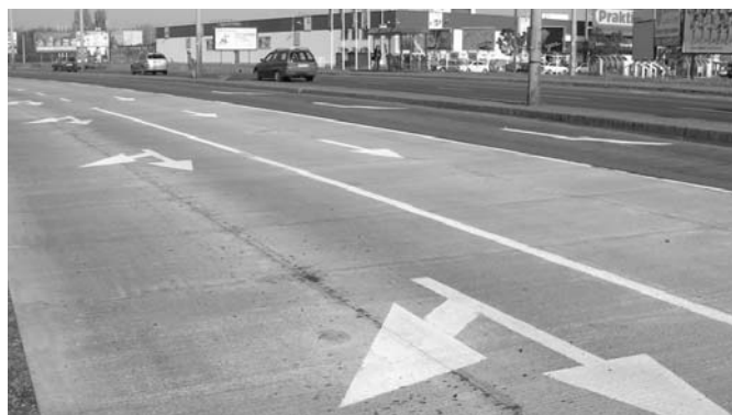
9. ábra A kísérleti szakasz helyszíne a felújítást követően
