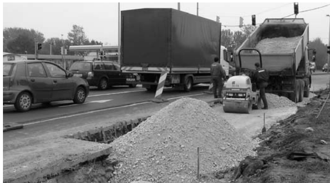
6. ábra M50 mechanikai stabilizáció építése
