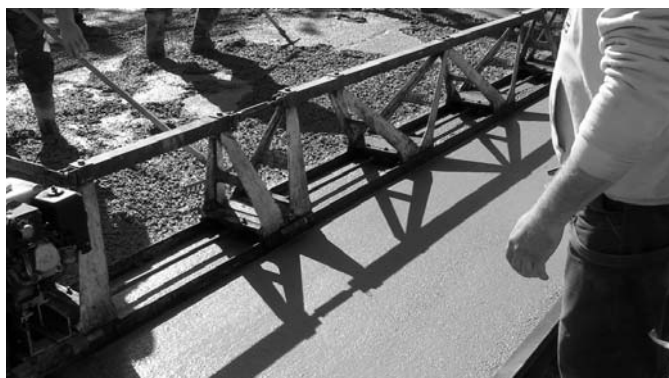
7. ábra Betonburkolat építése kézi módszerrel
