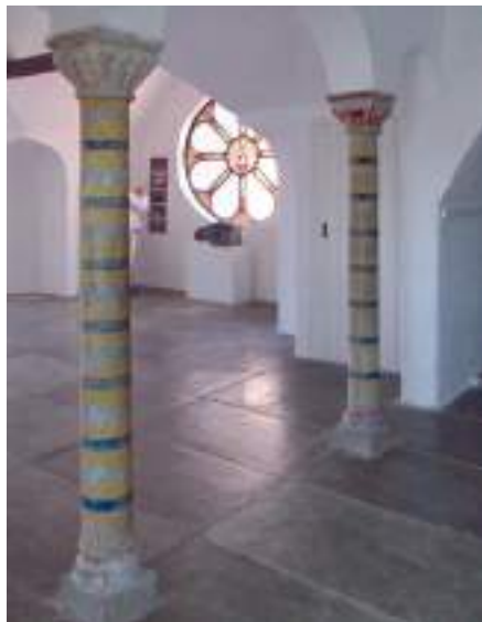
9. kép Megkapó látvány a rózsablakon beszűrődő fény játéka a beton lapokból készült, fényezett padlón. Az anyag időtlenségét bizonyítja, hogy ezek a padlólapok 60-70 évesek. A beton alkalmas a nagyon karcsú oszlopok elkészítésére is. Kivételesen szép arányú ennek a térnek a belső megjelenése
