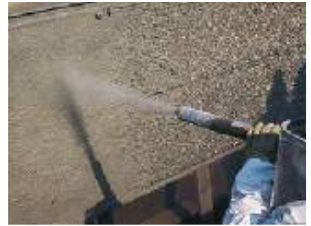
2. kép Megerősítés lőttbetonnal
