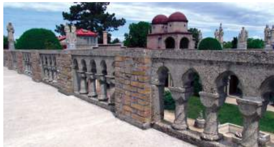
2. kép A belső udvart a kerengő felett körbe lehet járni, a téglabetétes mellvéd meghatározó eleme a betonoszlopos könyöklő
