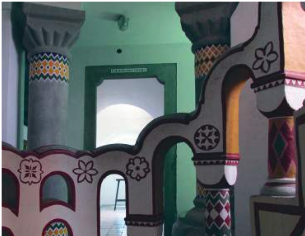
10. kép Az épület belső hangsúlyos elemei a beton oszlopok és a különösen szép beton korlát. Itt is megjelenik a beton díszítő festése. Az oszlopok beton textúráját szépen hangsúlyozza a mértékkel alkalmazott festés
