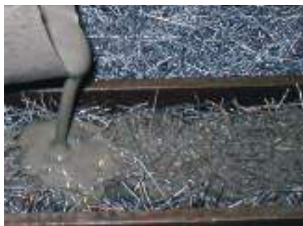
7. kép SIFCON beton készítése [10]
