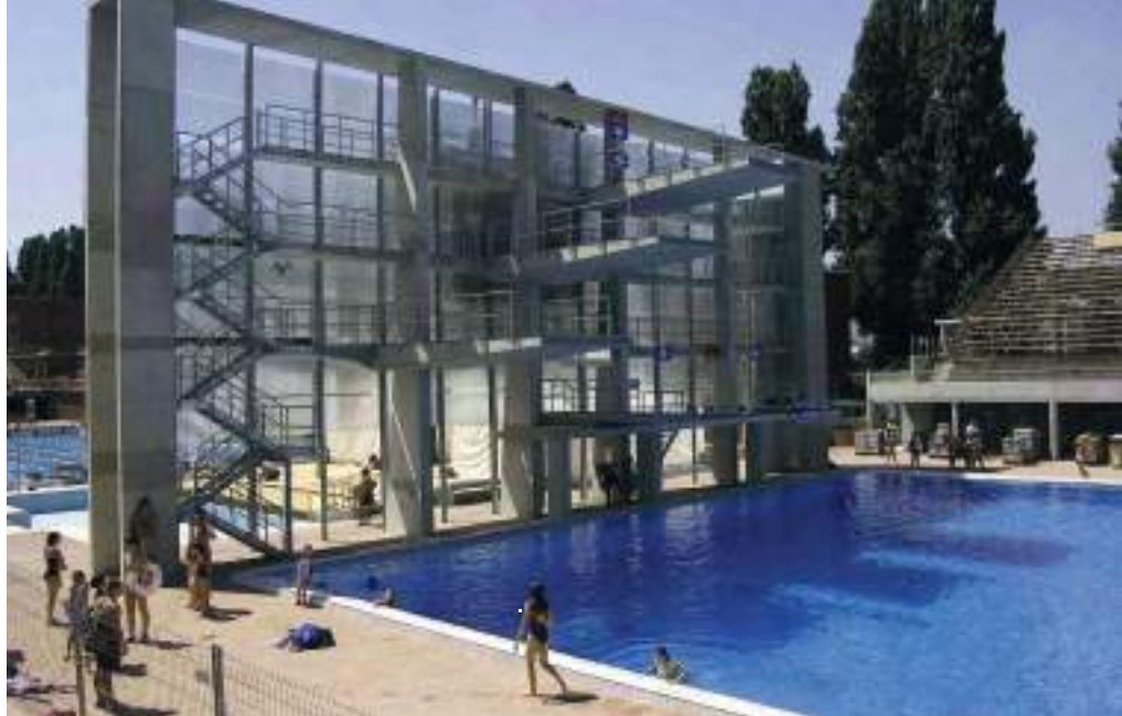
5. kép Széchy Tamás uszoda (Budapest, Margitsziget) [8]
