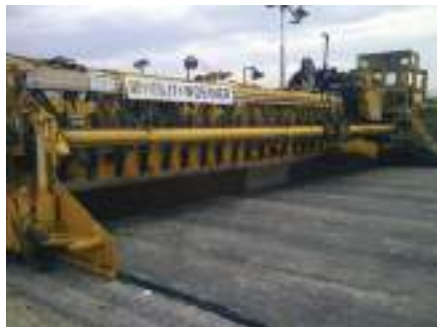
2. kép A próbaszakasz kivitelezési munkái
