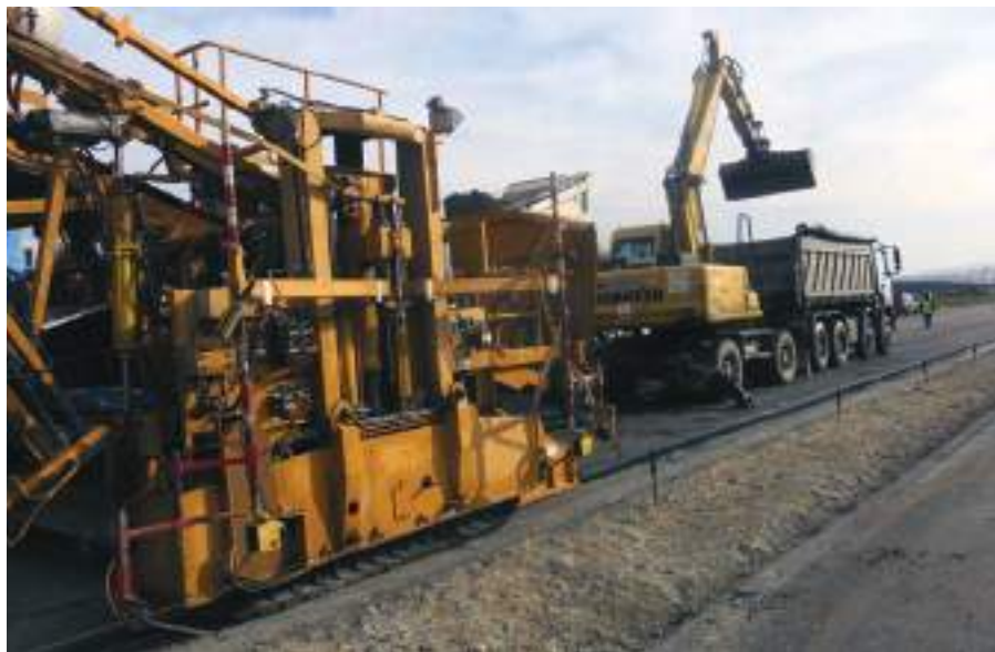
1. kép Beton pályaburkolat készítő géplánc kivitelezés közben
