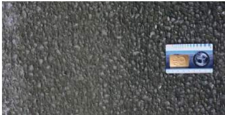
3. kép Beton pályaburkolat felső rétegének mosott beton kialakítása
