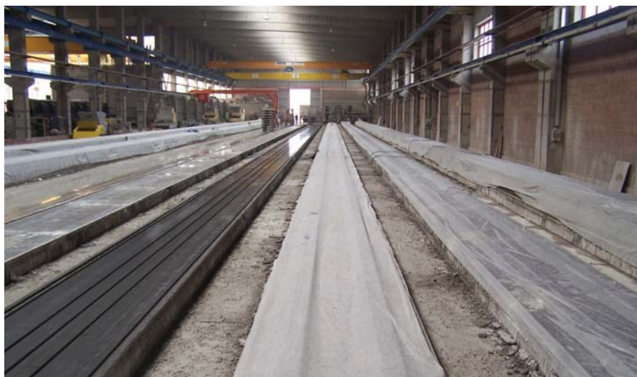
5. ábra A gyártócsarnok Majosházán
