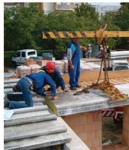
6. ábra Ez a kép bemutatja a helyesen elkészített falegyent, a ledugózott üregű MF panel gondos elhelyezését és az emelőhimba szakszerű használatát is
