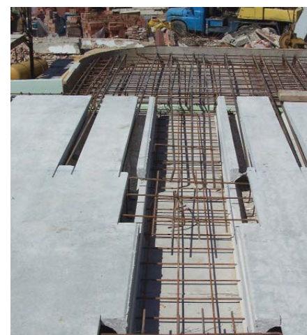
7. ábra Vasalási példa: az erkélylemez vasalása benyúlik a bevágott panelbe, és beköt a monolit szakaszba is
