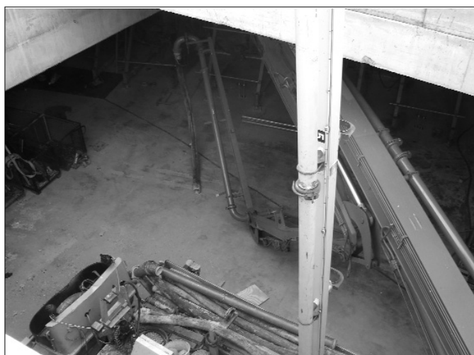
1. ábra A beemelt betonpumpa a lenti szinten
