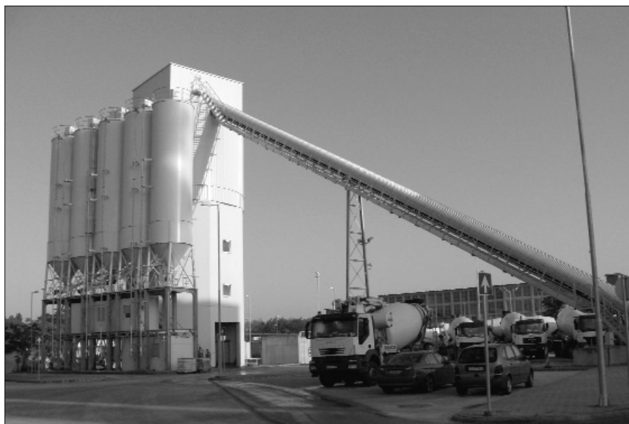
1. ábra Betongyár az Illatos úton Budapesten
