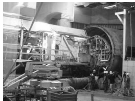
3. ábra A fűrőpajzs ideiglenes tartózkodása a körtéren
