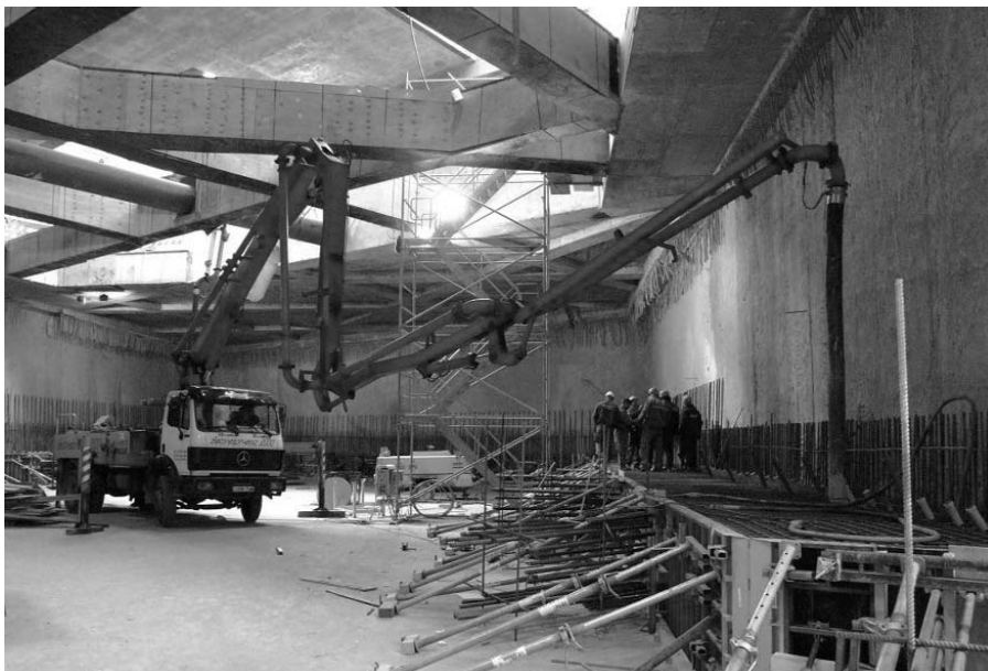
3. ábra Indulhat a betonozás
