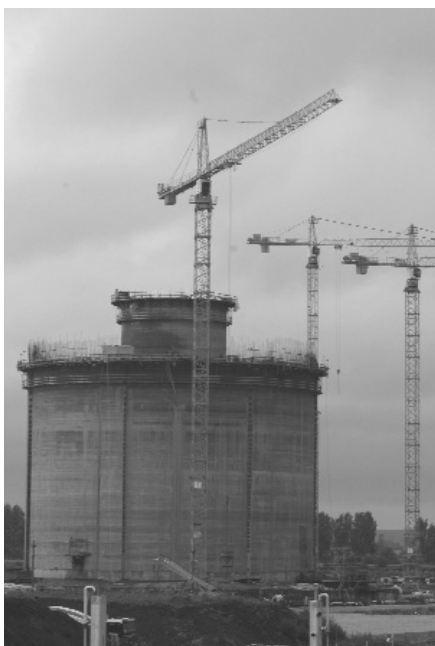
3. ábra A csúszószerkezetes technológia megköveteli a nem ragadós, hosszú eltartható, ennek ellenére kötési késleltetés mentes adalékszer cement kombinációt
