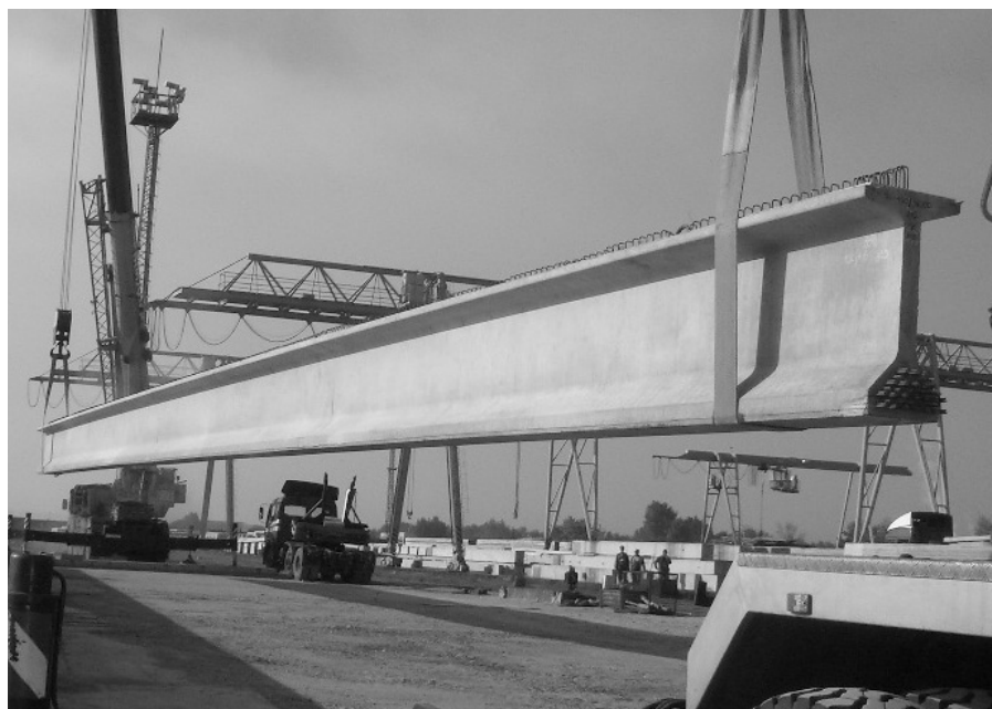
4. ábra Az FI-150 hídgerenda kiszállítása a tárolótérre
