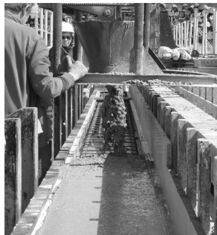
2. ábra Előregyártás öntömörödő betonnal
