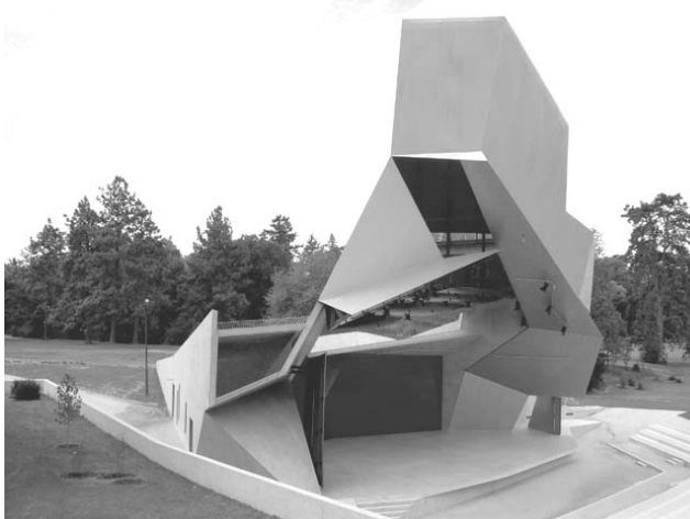
1. ábra A szabadtéri színpad ferde falakból álló épülete látszóbetonból (Ausztria, Grafenegg)
