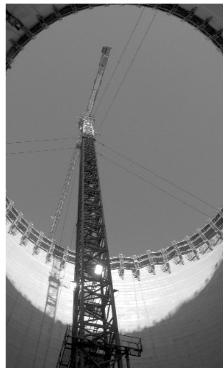
5. ábra Nagy teljesítőképességű betonból épülő vasbeton hűtőtorony belseje
