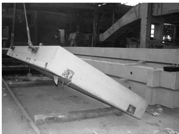
1. ábra Az elemek fordítása
