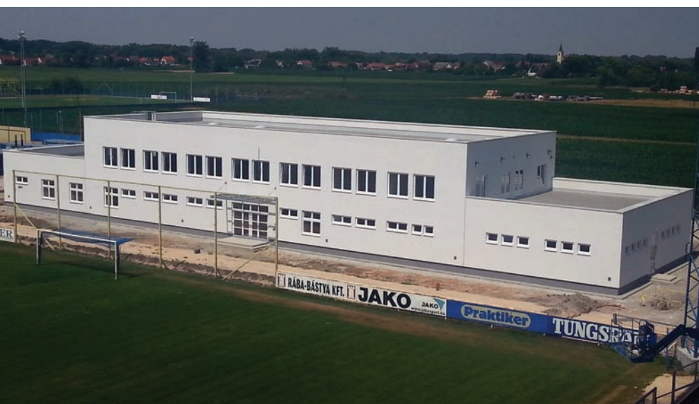
1. kép A főépület
