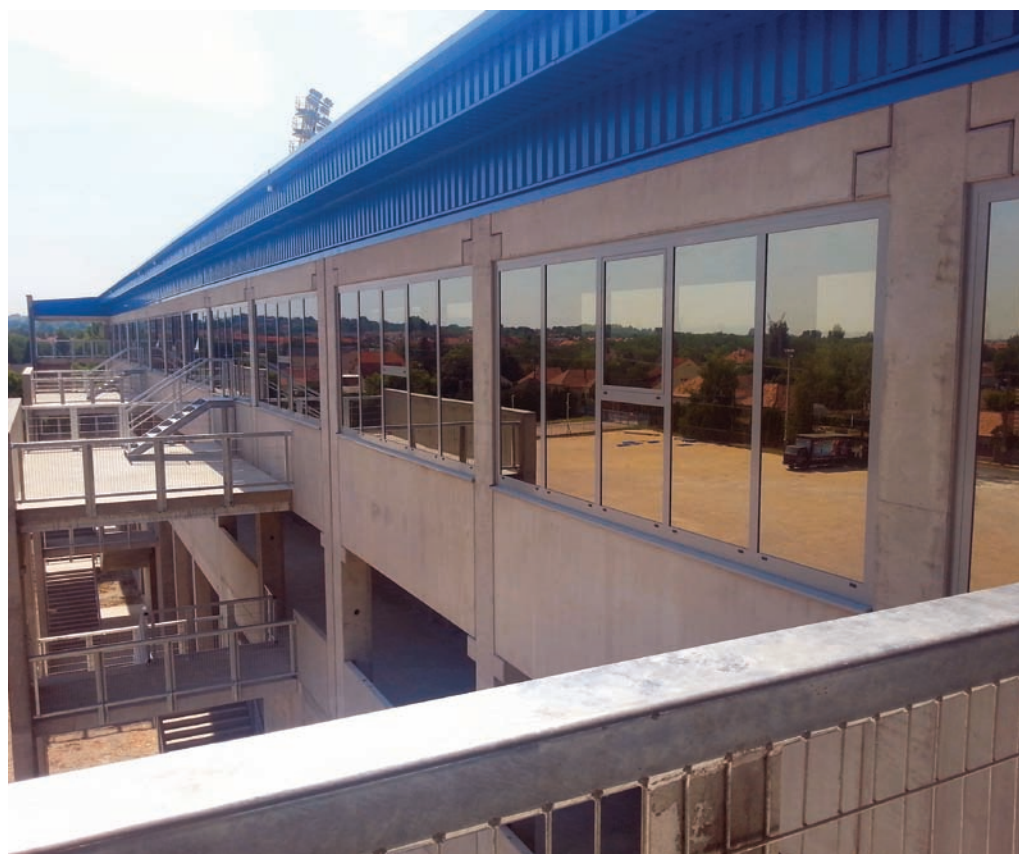
3. kép A lelátóépület homlokzata egységes, festetlen nyersbeton felületként jelenik meg
