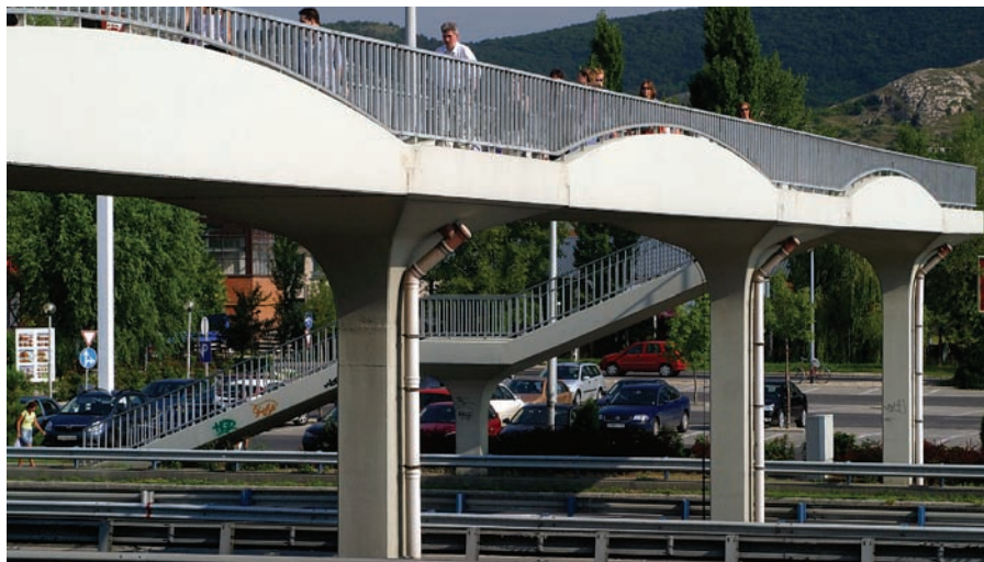
3. kép Egyedi kialakításúak a budaörsi pillérfejek. A műanyag cső a vízelvezető rendszer része
