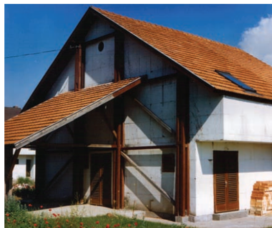
2. kép Négylakásos, átriumos ház gipszbeton szerkezettel (Dunaújváros, 1986-89)
