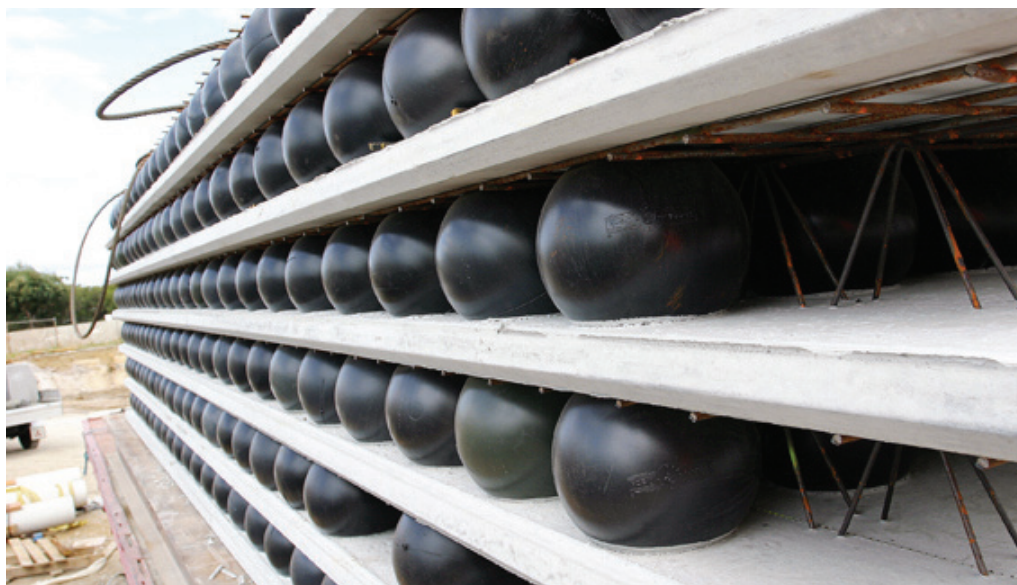
3. kép Félkész monolit panelek [6]
