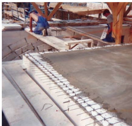
1. kép Gipszbeton ívek és felső védőlemez építési fázisa (Visegrád)
