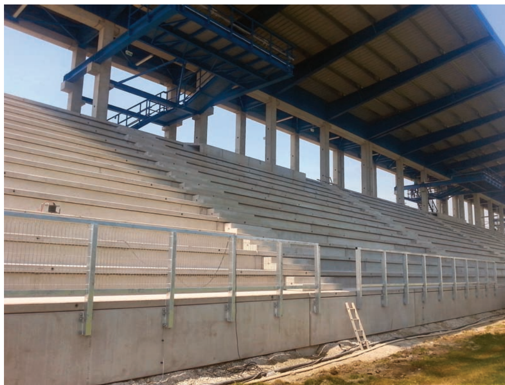
4. kép A tetőszervezetet biztosító, konzolosan benyúló acél tartók és szélrácsok kivitelezését az előregyártott vasbeton szerkezet építéséhez ütemezték
