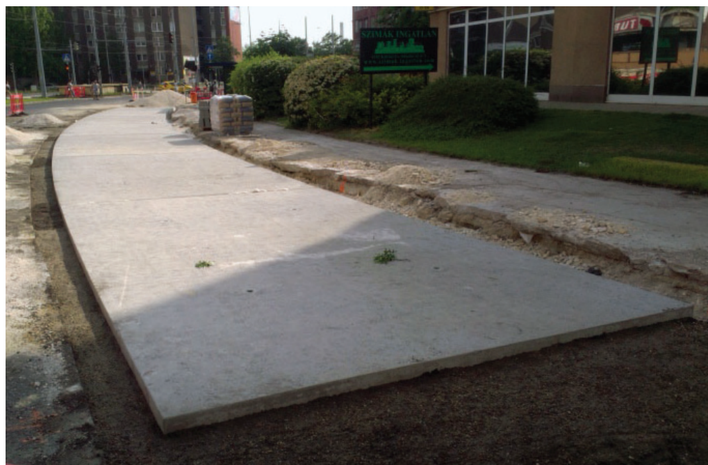
2. kép Beemelt buszöböl panelek, injektálás előtt
