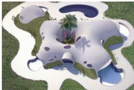
4. kép Felfújható zsalluzattal, a kupolák összemetszésével kialakított üdülőegység [9]
