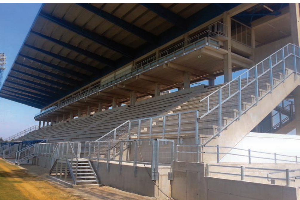
2. kép Az északeleti oldalon lévő lelátó egy többszintes épület, melyben a szurkolói nézőtér és a sajtó számára kialakított lelátóhelyek mellett az elkülönült földémszinten VIP lelátóhelyek kerültek kialakításra
