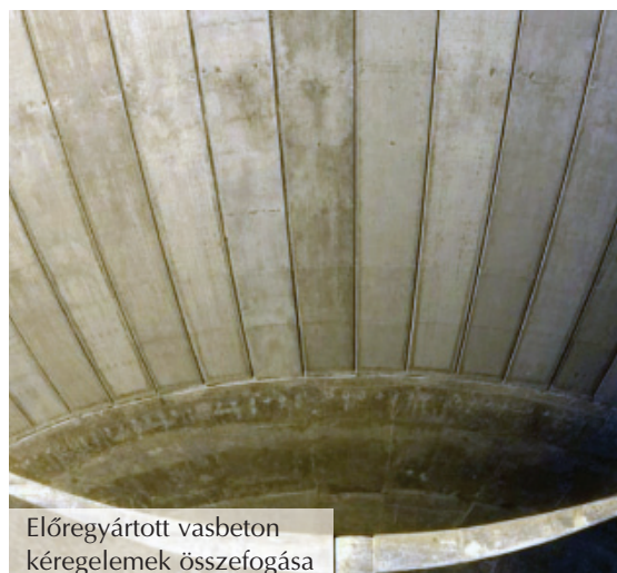
Budafoki víztorony építés, kehelycikkelyek beemelése után
