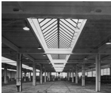
2. ábra 9x9 m-es típus vasbeton csarnokváz
