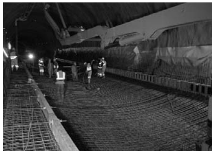
4. ábra Ellenbóltív betonozás
