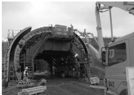
6. ábra Portál boltív betonozás
