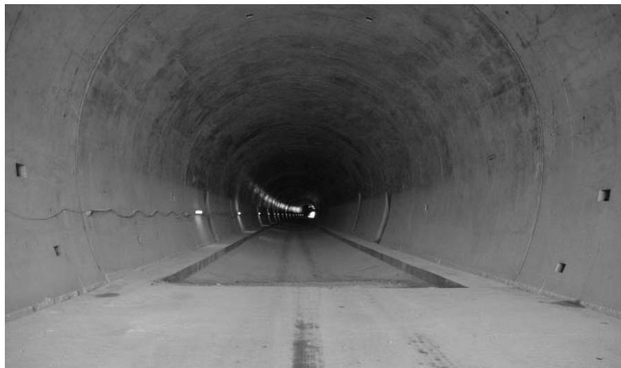
8. ábra Az alagút betonfelülete
