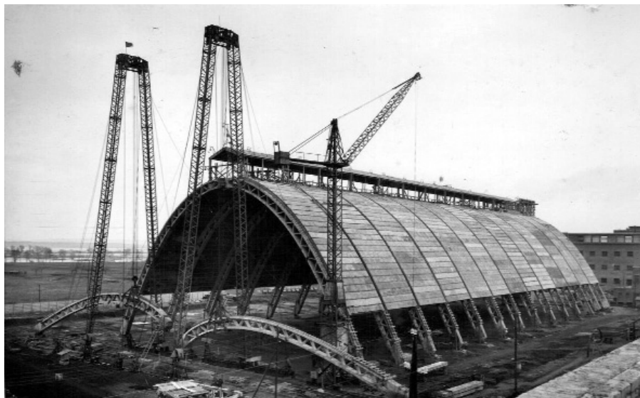
1. ábra A kazincbarcikai "sóraktár" vasbeton tartószerkezete
