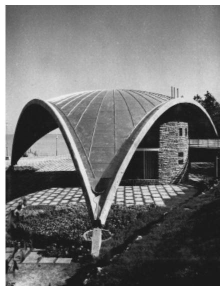
4. ábra A tihanyi postapavilon vasbeton héjszerkezete
