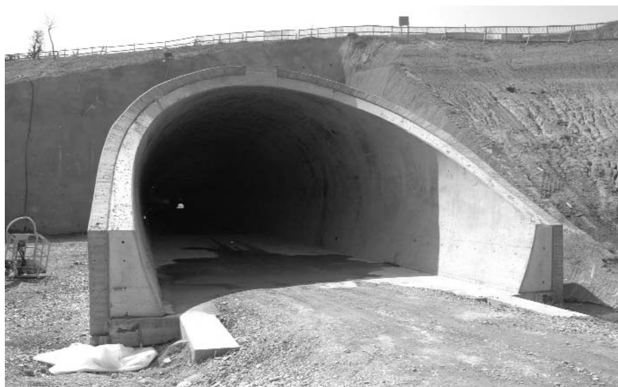
7. ábra Az alagút bejárata
