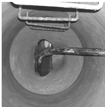
2. ábra Korrodálódott akna javítás után
