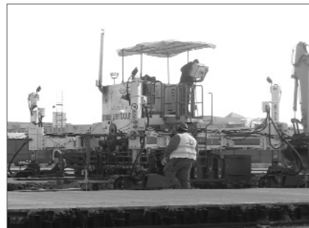
2. ábra A betonfiniser munka közben
