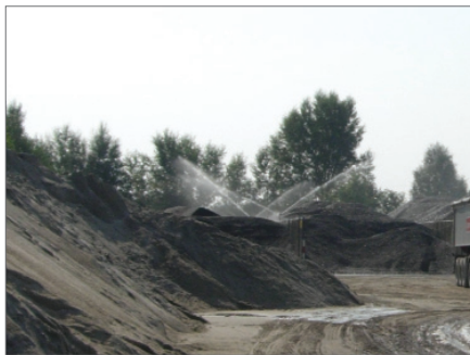
3. ábra Az adalékanyag hűtése vízpermettel
