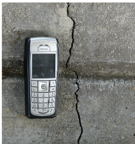
2. ábra Zsugorodási repedés
