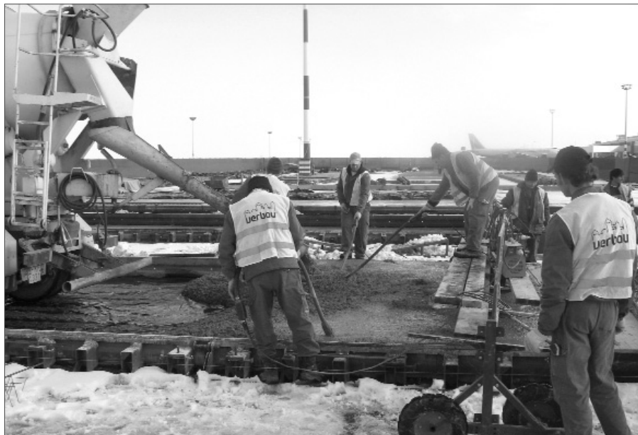
3. ábra A téli hónapokban szükségessé vált a kézi bedolgozás
