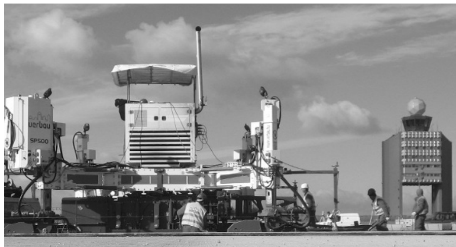
1. ábra A térbeton készítése 2008. novemberben
