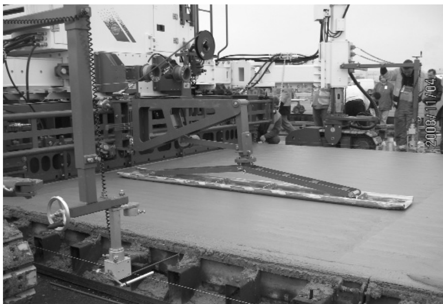
4. ábra A betonfelület simítása
