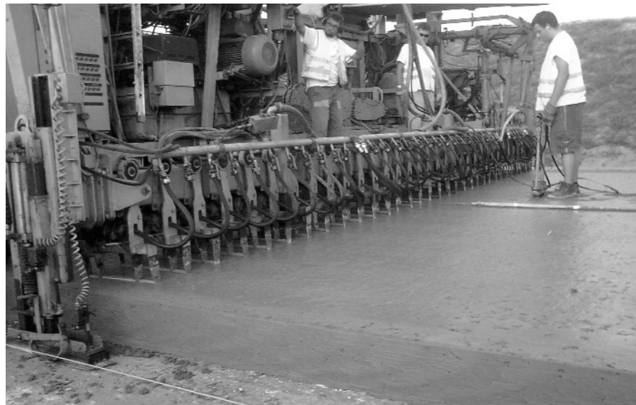
1. ábra Hézagvasak elhelyezése
