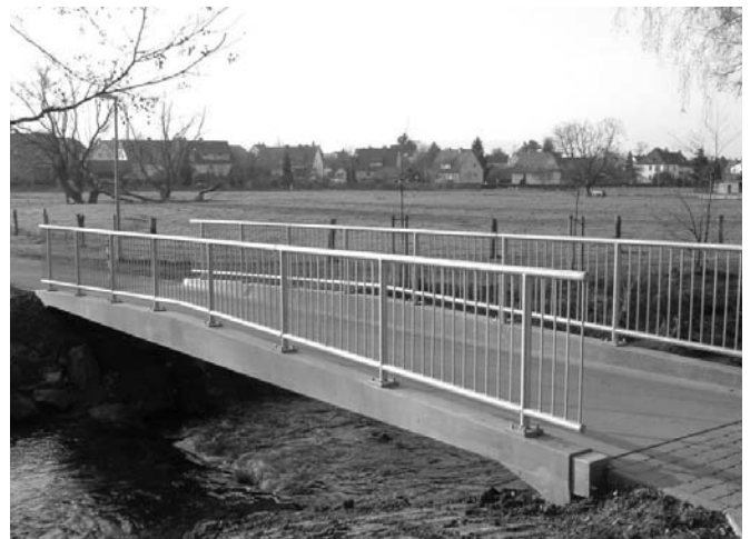
1. ábra Gyalogos és kerékpáros híd a Nieste folyó felett, Kasselben, ultra nagy szilárdságú előregyártott feszített vasbetonelemből. Fesztávolság: 12 m, lemezvastagság: 10 cm, szegélymagasság: 40 cm. A 12 tonnás elemet autódaruval emelték a helyére.
