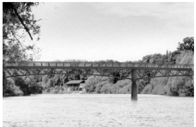
2. ábra A Fulda folyó felett átívelő, 140 m hosszú Gärtner téri híd Kasselben, ultra nagy szilárdságú, szálerősítésű betonból készített, keresztirányban előfeszített, 5 m széles és 8,5 cm vastag pályalemezzel, és a pályalemezt alátámasztó, hosszirányban utófeszített övvel.
