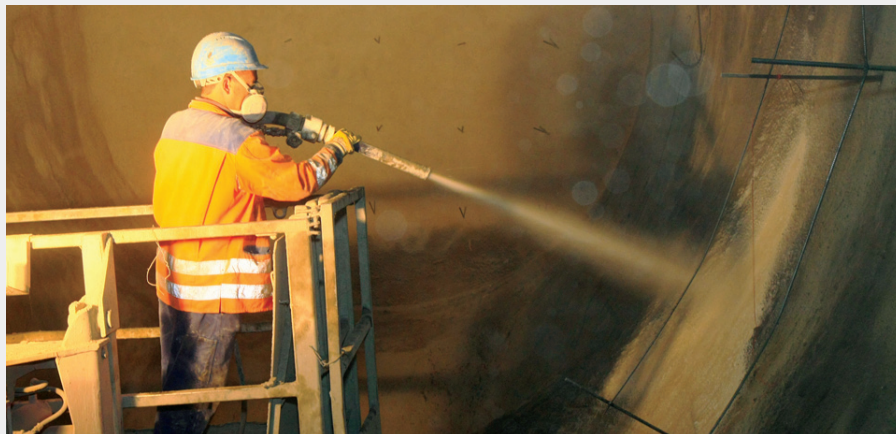
3. ábra Membránszigetelés szórása
