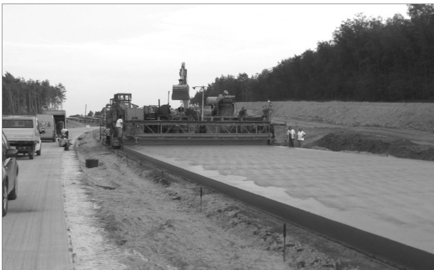
1. ábra A frissen elkészült beton pályalemez
