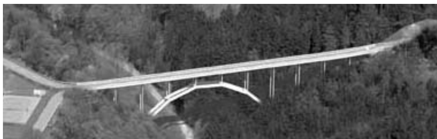
3. ábra Az ausztriai Völkermarktban, a Mühlgraben (Malomárok) feletti részben szálerősítésű ultra nagy szilárdságú betonból épült közúti híd.
