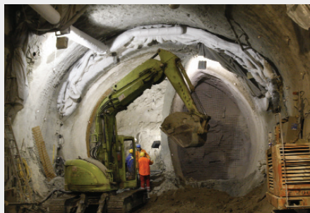
1. ábra Földfejtés talajfagyasztás mellett
