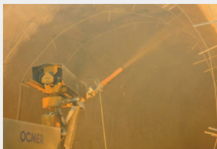
2. ábra Acélhajas beton lövése robotgéppel
