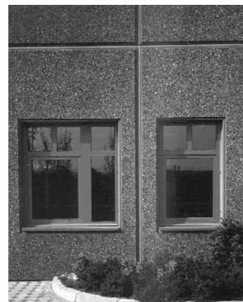
2. ábra Lezárandó panel-hézagok a homlokzaton
