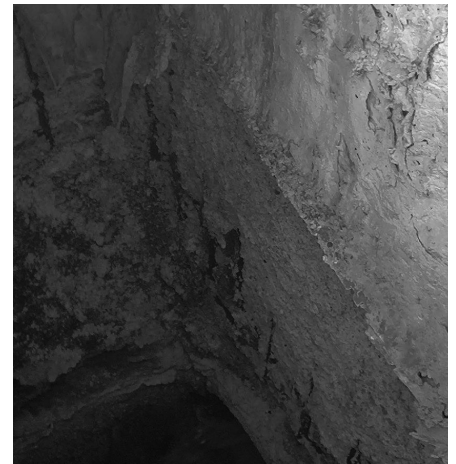
2. ábra Szennyvízknák jellemző károsodása
