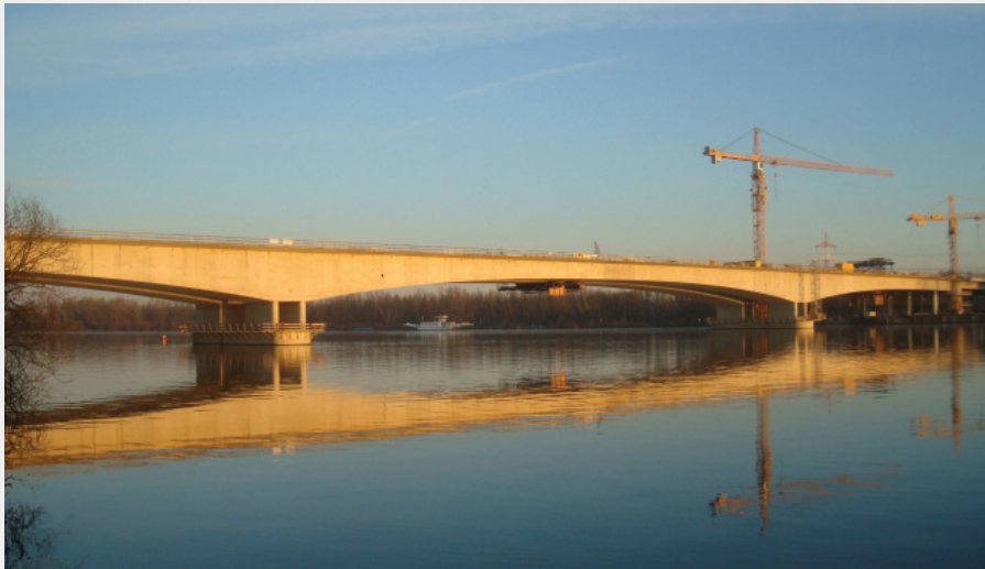
2. ábra Traismauer Duna-híd
