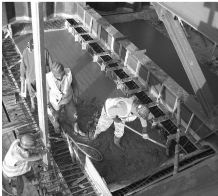
5. ábra Alsó lemez betonozása (2010. április)
