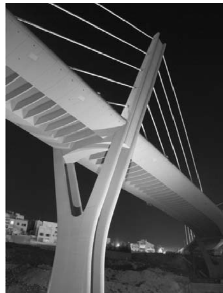
5. ábra fib Kiemelkedő Szerkezetek Díjat kapott 2010-ben: többtámaszú, ferdekábeles híd Y-alakú pilonokkal és S-alakú alaprajzi vonalvezetéssel, Ammán (Jordánia)
