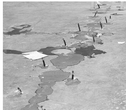
10. ábra Ipari csarnok aljzatának injektálása
