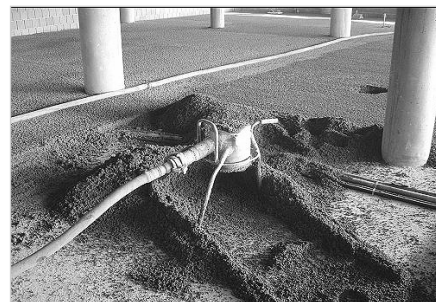
6. ábra Födém-szigetelés ÖKOCELL-Csend hő- és hangszigetelő betonnal
