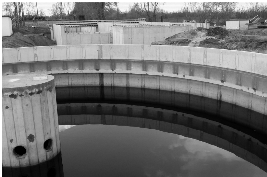
6. ábra Az ülepítő medence víztartási próbája
