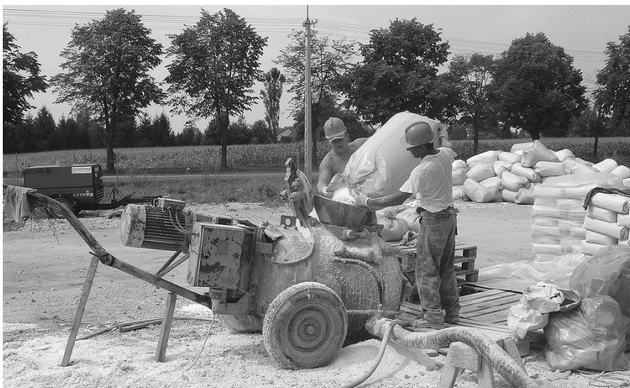
5. ábra Polisztirol beton előállítása Mixokret betonkeverőben
