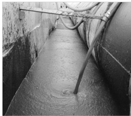
9. ábra Közművezeték munkaárok feltöltése habbetonnal
