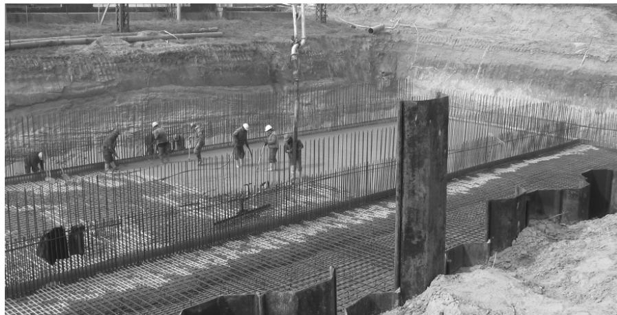
2. ábra Alaplemez betonozása
