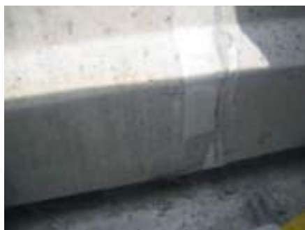
7. kép Beépítés után már csak az avatott szem veszi észre, hogy a tartó három darabból készült
