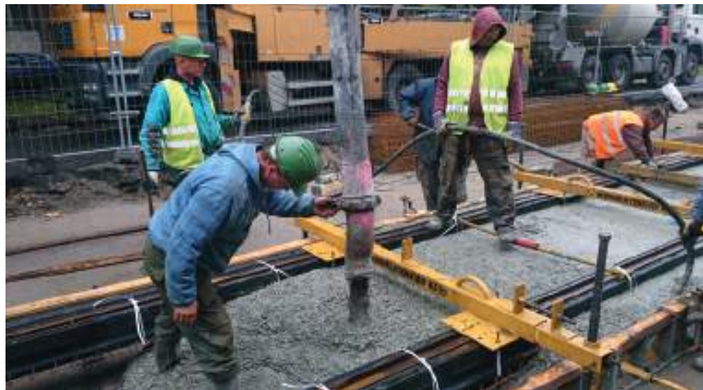
4. kép A fonódó villamospálya betonozása Budapesten
