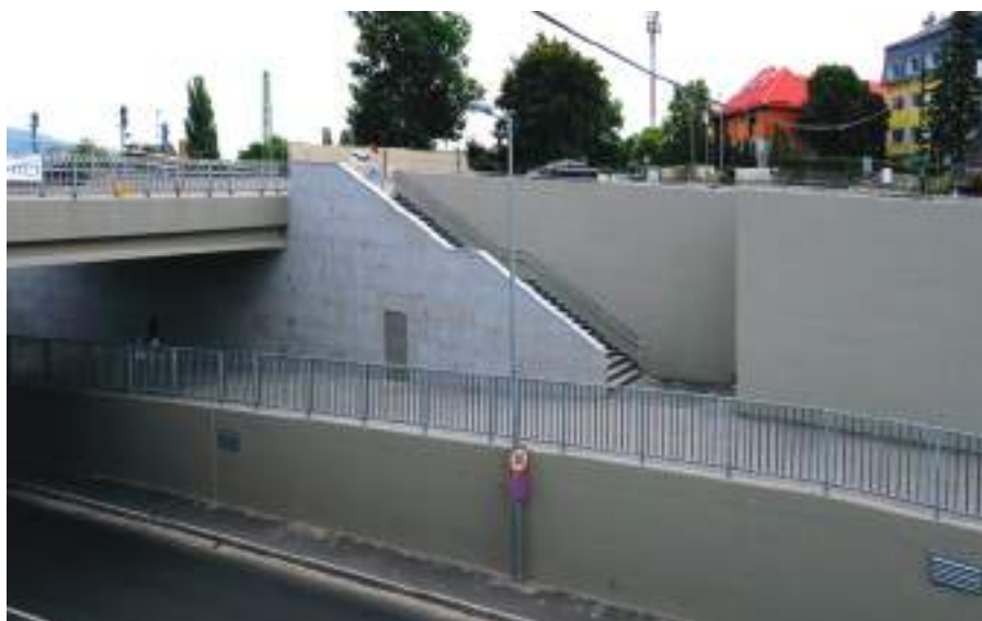
2. ábra Az aluljáró betonfala Pilisvörösvárnál
