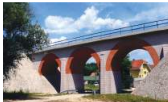
3. ábra Tó utcai viadukt
