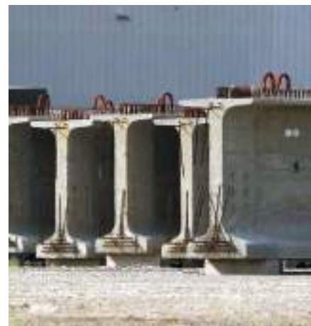
5. kép Hídgerendák beépítésre várva
