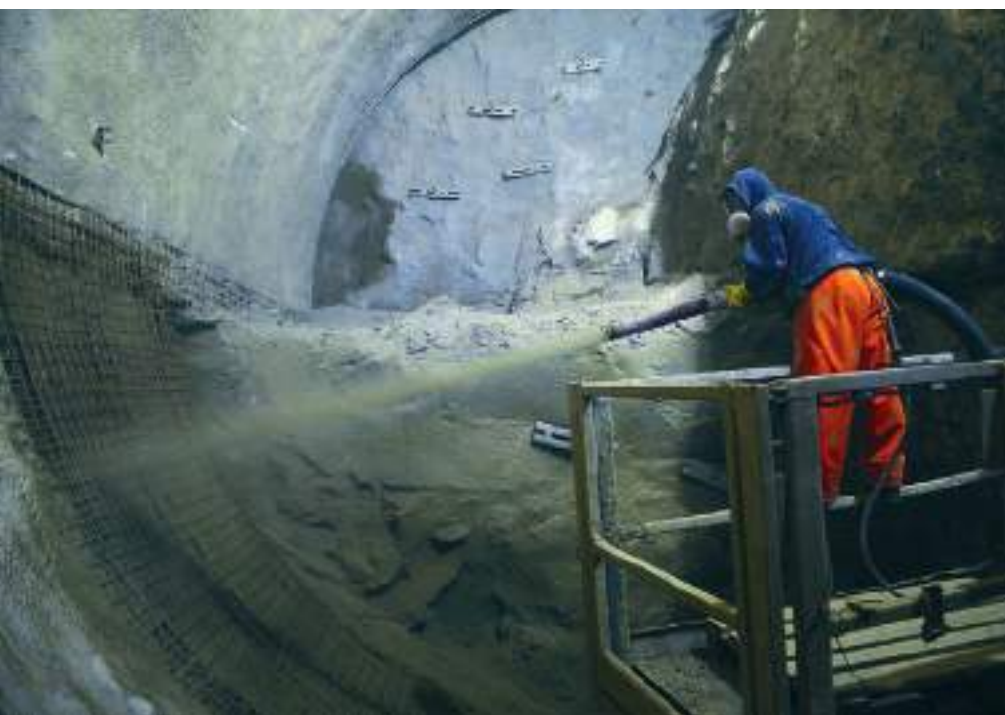
1. ábra Az alagút falának megerősítése acélhálóval és löttbetonnal az M4 metró építése során
