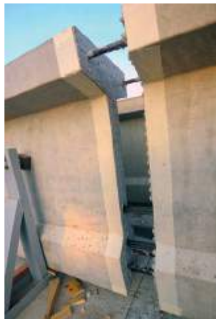
5. kép A feszítés megkezdése előtt a „lány” felületre felkenik a habarcsot
