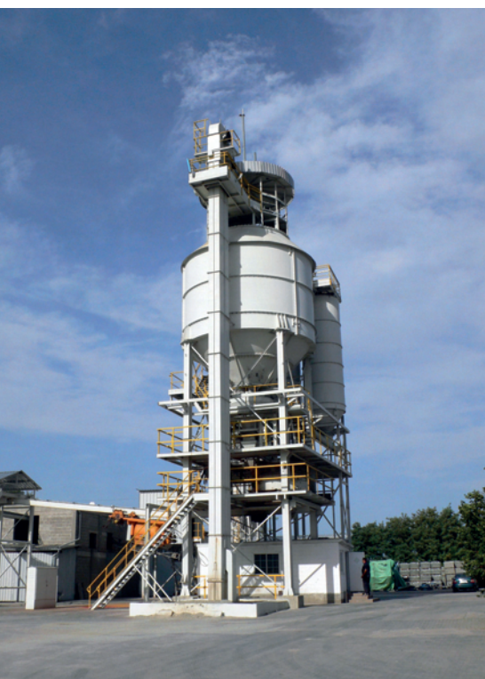
1. kép Központi betonkeverő a betonEPAG taksonyi telephelyén
