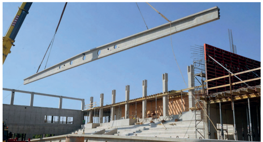
9. kép A három szegmensből összefeszített, 40 m hosszú gerenda beemelése
