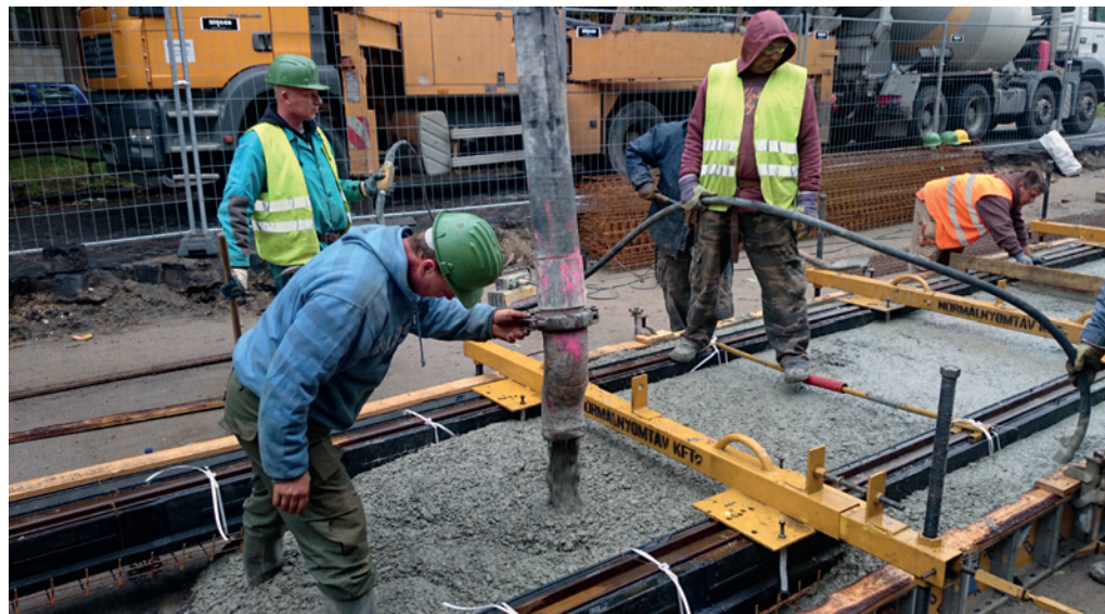
4. kép A fonódó villamospálya betonozása Budapesten
