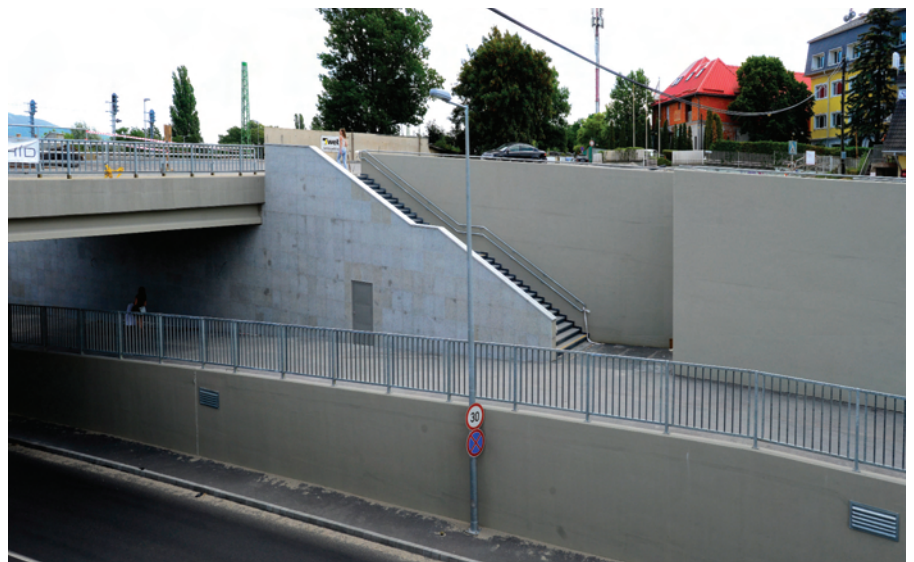
2. ábra Az aluljáró betonfala Pilisvörösvárnál
