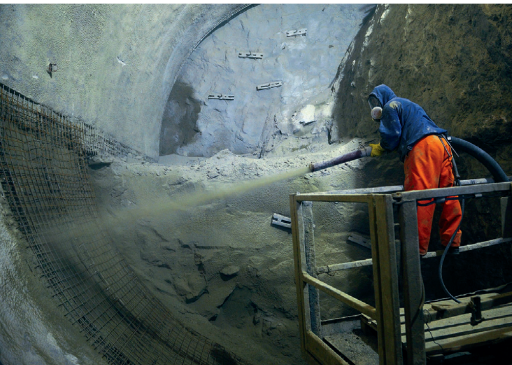
1. ábra Az alagút falának megerősítése acélhálóval és lötbetonnal az M4 metró építése során
