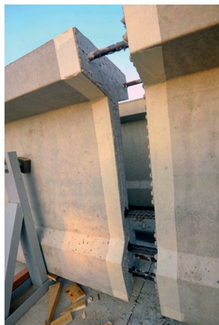
5. kép A feszítés megkezdése előtt a „lány” felületre felkenik a habarccsal
