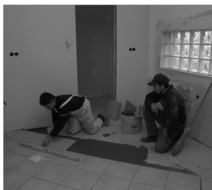
8. ábra 2010. október 22. befejeződik a belső burkolás
