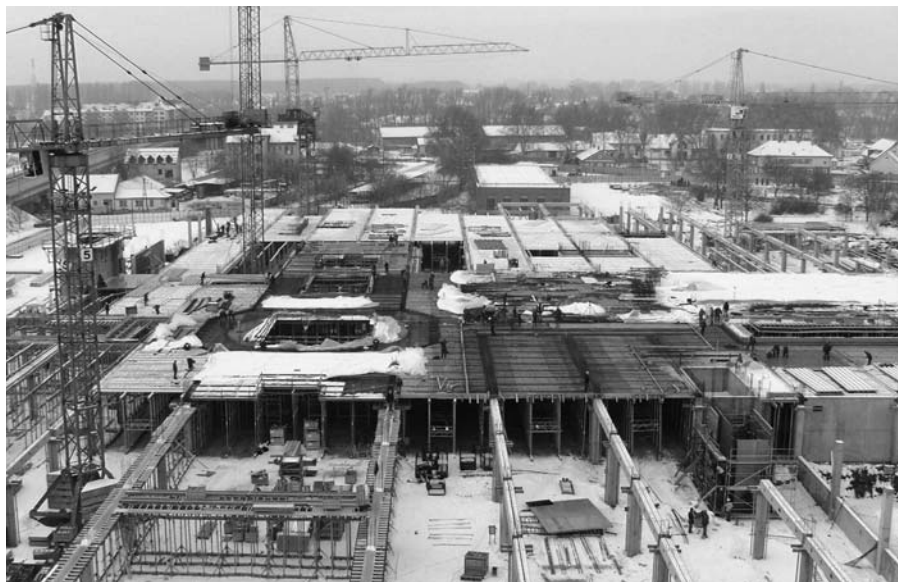
1. ábra Monolit földem vasszerelése Győrben
