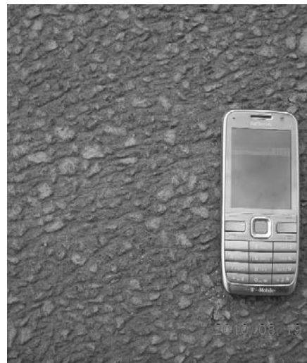
4. ábra Az elkészült mosott beton útburkolat
