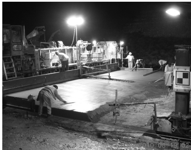
3. ábra Kézi és gépi simítás
