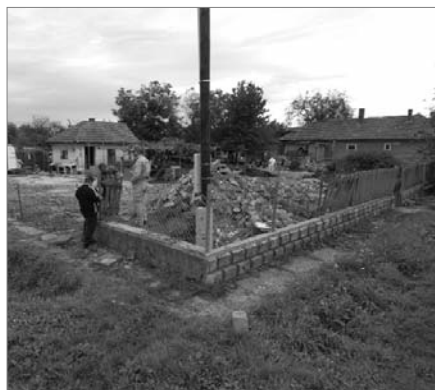
2. ábra 2010. szeptember 15. romeltakarítás közben
