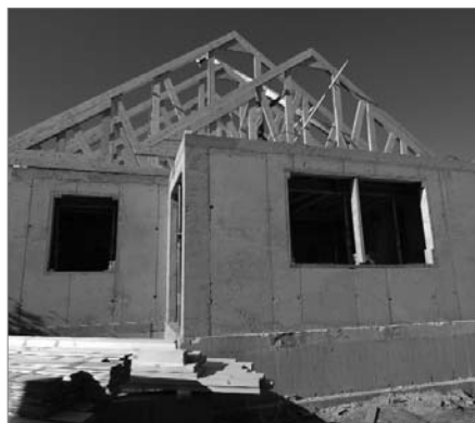
4. ábra 2010. október 7. állnak a tartófalak és kész a födém
