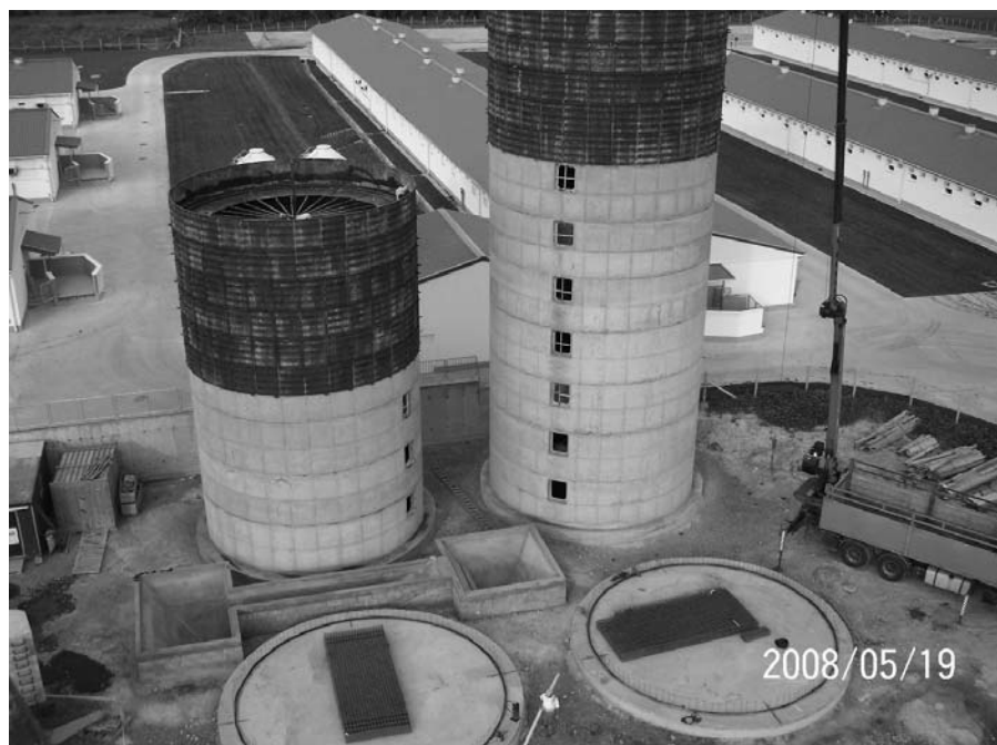
1. ábra Silók építése Dalmandon
