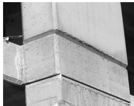
7. ábra Munkahézag kialakítása vonalszerű lenyomattal
