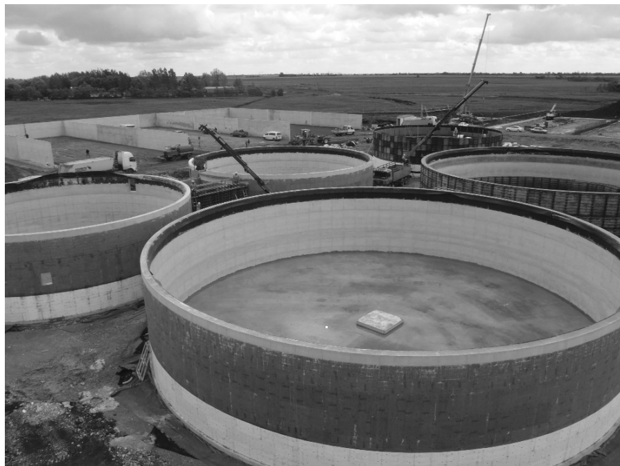
2. ábra Biogáz üzem építése Szarvason
