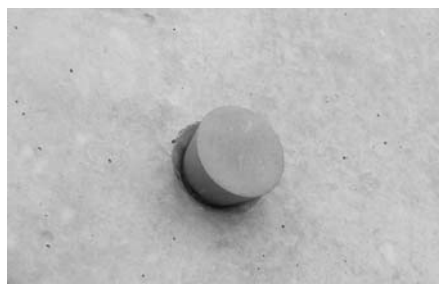
5. ábra Átkötési helyek eltiűntetése beton dugóval
