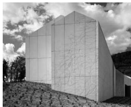
3. ábra Borászati beruházás vasbetonból
