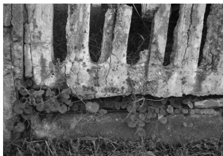
1. ábra Karbonátosodás, fagyás és gondozatlanság okozta mállás
