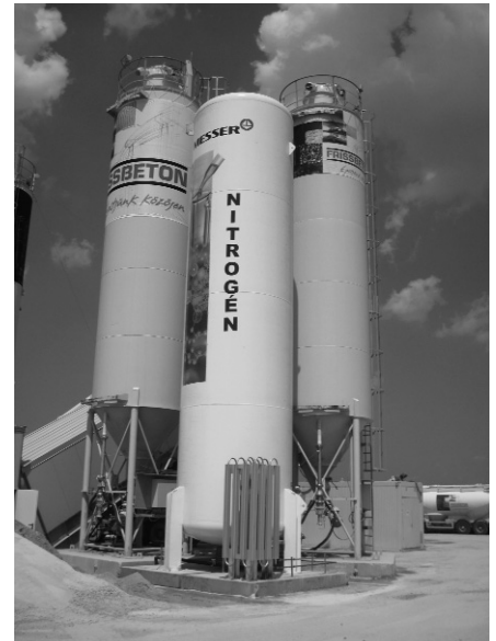
1. ábra Betongyári installáció
