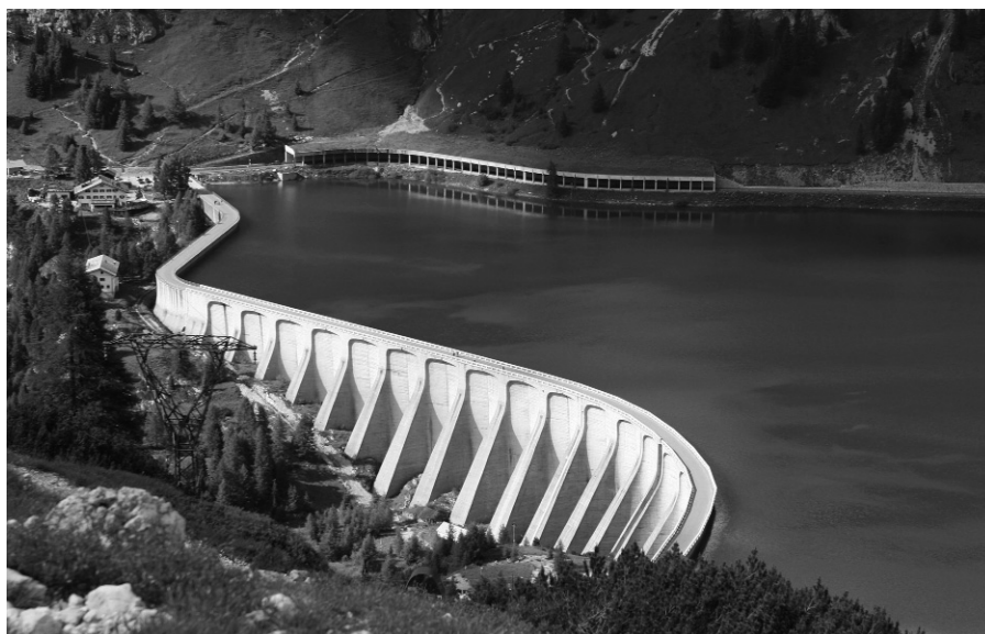
2. ábra Völgyzárógát Sika ViscoCrete technológiával megépített betonszerkezete
