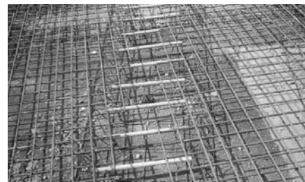
7. ábra Betonacél háló - a hézagokban kereszt-hézag vasakkal
