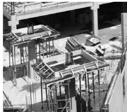
3. ábra Betonozásra váró szerkezet
