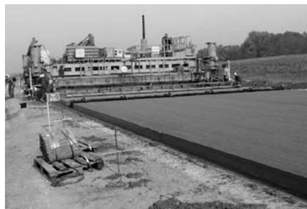
6. ábra A főpálya építése
