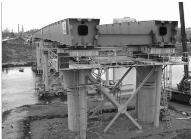
2. ábra Folyamatban az acélszerkezet tolása
