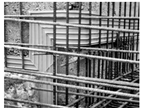
2. ábra Sika PVC fugaszalagok beépítése Rugalmas kialakításúak és megakadályozzák a víz átjutását, ezáltal biztosítva a hézagokban mind a vízzáróságot, mind a mozgás lehetőségét alacsony és magas víznyomás esetén is.
