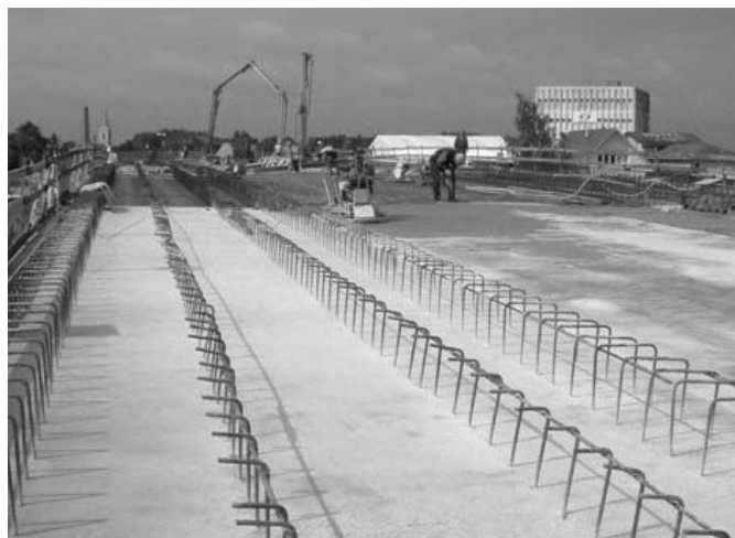
3. ábra Folyamatban a pályalemez betonozása
