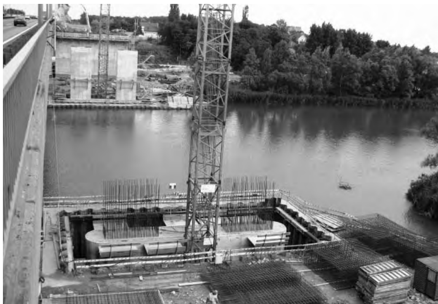
3. ábra A mederpillérek cölöpösszefogó gerendáira állították fel a toronydarukat
