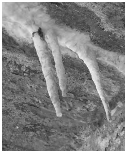
2. ábra Tömítetlen fugán át kifolyt, függő cseppkőként megszilárdult karbonátalakzat
