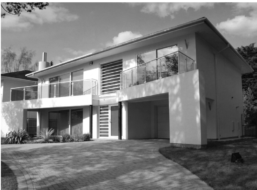
1. ábra Beázások, nedvesedések megelőzése érdekében fontos a megfelelő szigetelőrendszer betervezése és szakszerű kivitelezése
