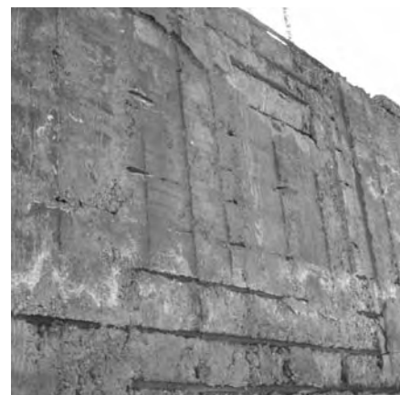
3. ábra Ha a beton szabad mésztartalma teljesen kifogy, a rozsdásodás beindul, és kirajzolódnak a külső acélháló vonalai
