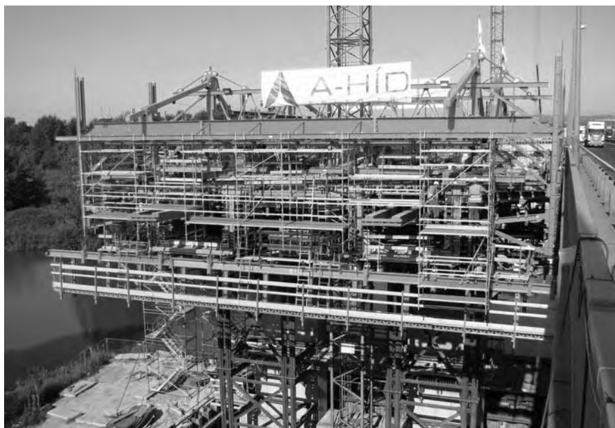
4. ábra Elkészült az indítózöm állványzat
