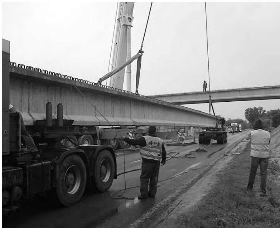
4. ábra Leemelés a szállító eszközről
