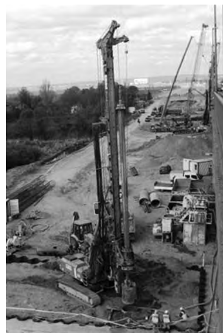
1. ábra A mederpilléreket műszigetről építették
