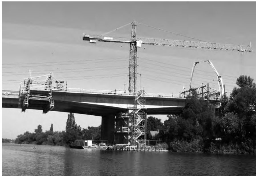
5. ábra Üzembe helyezték a zsaluzó kocsit
