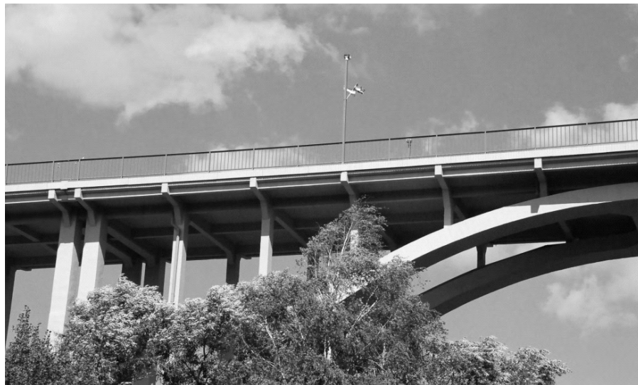
4. ábra Teljes szépségében a megjavított hídszerkezet
