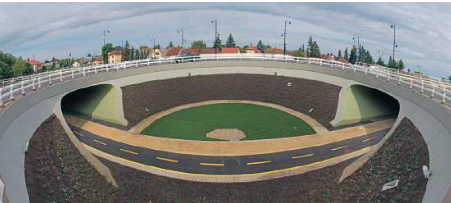
9. kép Előregyártott szegély elemek a belső lencsében
