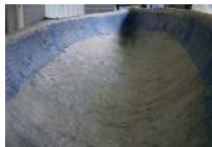
7. kép A peremet erősítő háló elhelyezése
