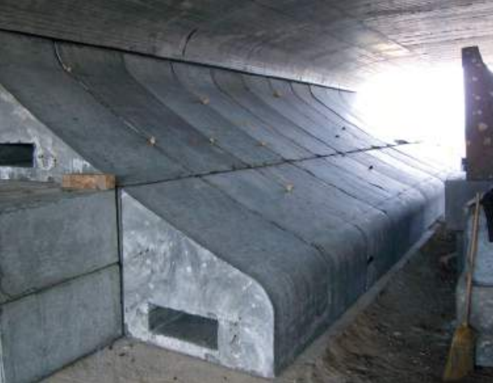
8. kép A belső geometria kialakítása előregyártott elemekkel
