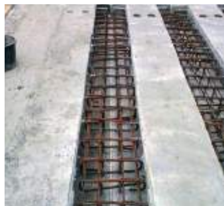
6. kép Az előregyártott elemek közötti együttdolgozást biztosító kapcsolat
