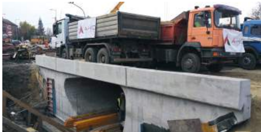
7. kép A B3 jelű műtárgy próbaterhelése
