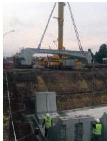
3. kép Előregyártott elem beemelése
