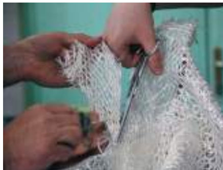
4. kép Az üvegszál háló méretre vágása
