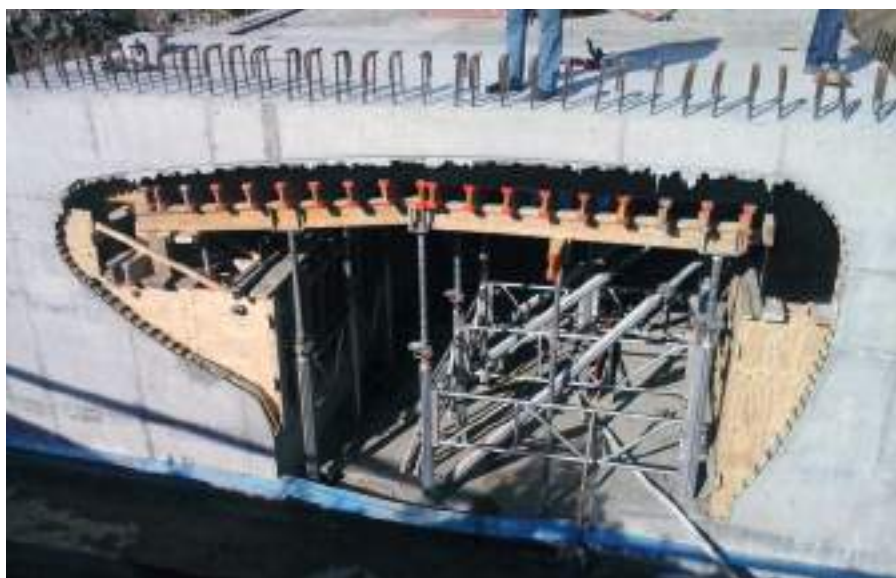
5. kép Zsaluzat a helyszíni betonozáshoz
