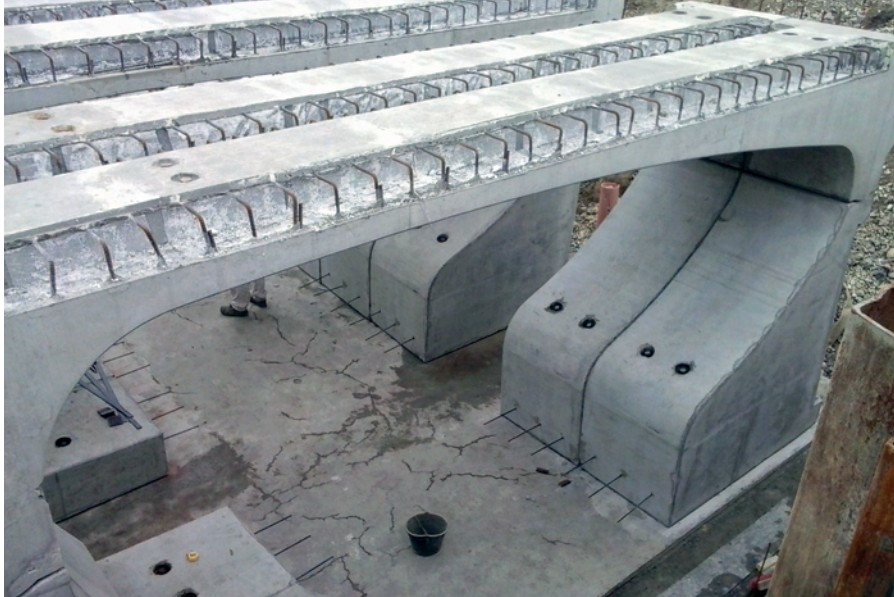
4. kép Az egyedi geometriájú elemek a helyükre kerültek
