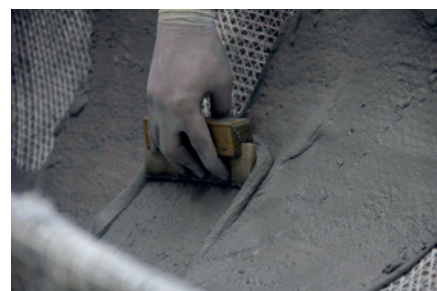
6. kép A beton bedolgozása
