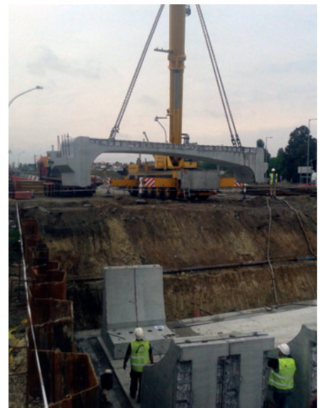
3. kép Előregyártott elem beemelése
