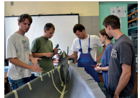
3. kép A zsaluleválasztó réteg rögzítése
