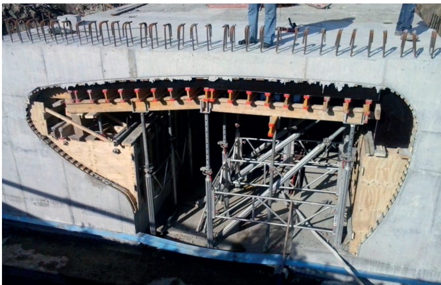
5. kép Zsaluzat a helyszíni betonozáshoz
