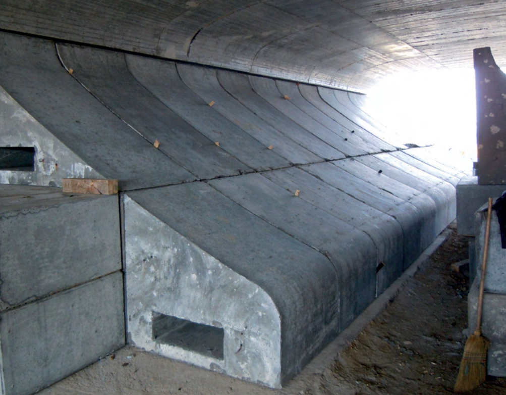
8. kép A belső geometria kialakítása előregyártott elemekkel
