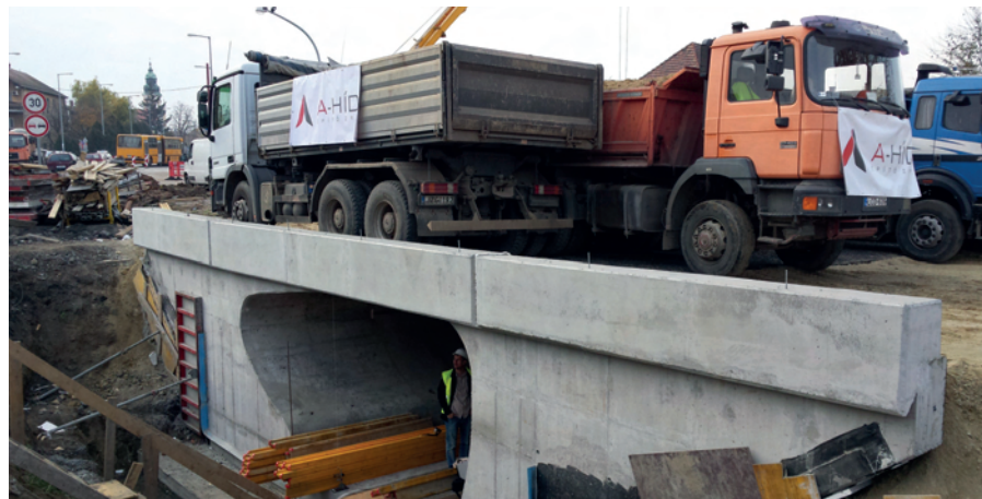
7. kép A B3 jelű műtárgy próbatelhelése
