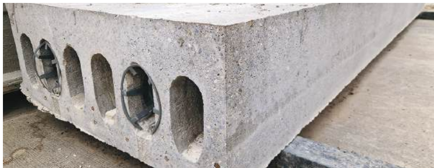
1. ábra: Földnedves betonból előállított üreges födémpanel, ahol a belső struktúra látható hossz- és keresztirányban
