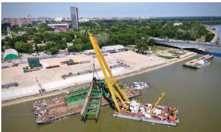
4. kép: Hídelemek tárolóbárkára helyezése
