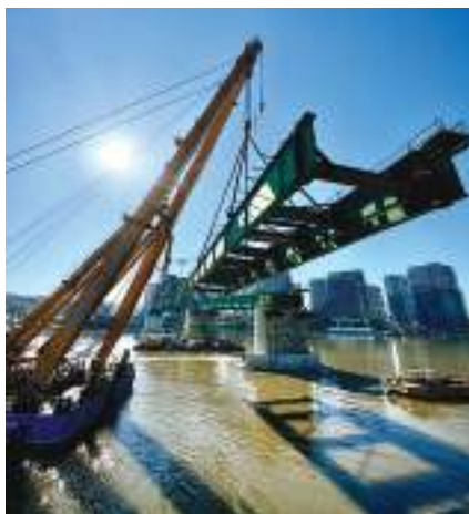
3. kép: Bal part 1-es hídelem emelés közben
