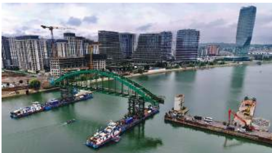
5. kép: Ívhíd emelése és úsztatása emelőműves bárkákkal. Tömeg 400 tonna
