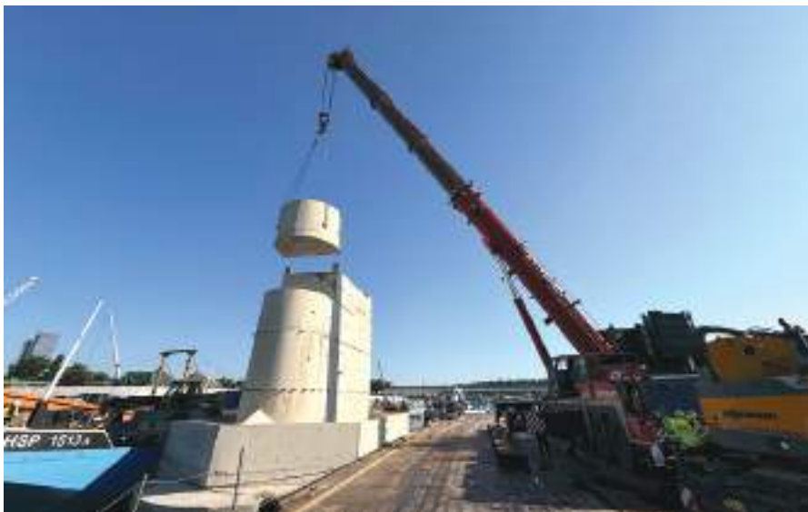
8. kép: Gyémántkötéles vágással feldarabolt pillér első elemének emelése. Tömeg: 75 tonna
