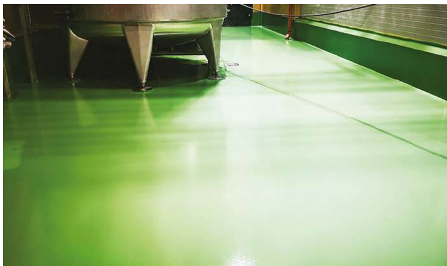
Élelmiszeripari műgyanta bevonat (forrás: Interfloor Kft.)
