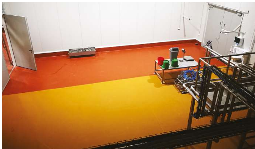
Élelmiszeripari műgyanta bevonat (forrás: Interfloor Kft.)
