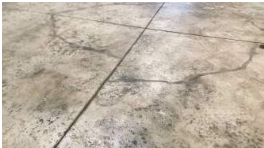
1. kép: Gyenge ágyazat miatti padlósüllyedés
