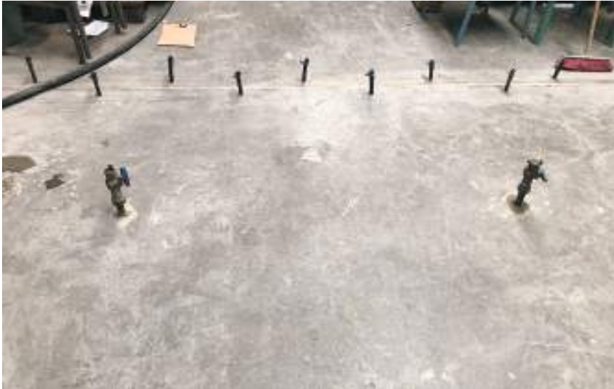
2. kép: Ipari padló fugái melletti injektálás, ami stabilizálja a felső ágyazati réteget.
