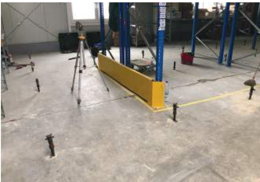
3. kép: Mélyinjektálás, ami az alépitményi rétegeket erősíti.
