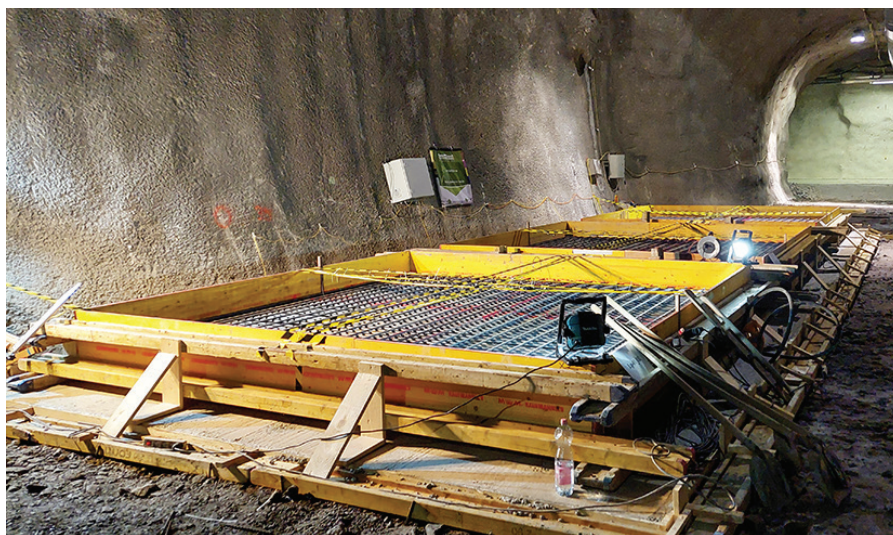
5. kép: Lemez próbatestek betonozás előtt
