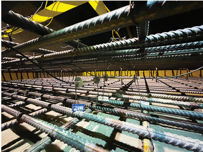
6. kép: Betonba szerelt szenzorok
