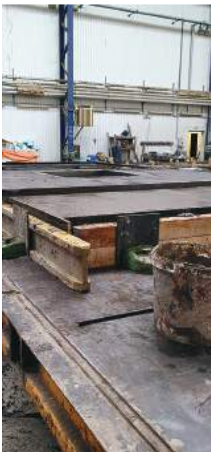
Nehézbeton tároló vibrálás és simítás után
