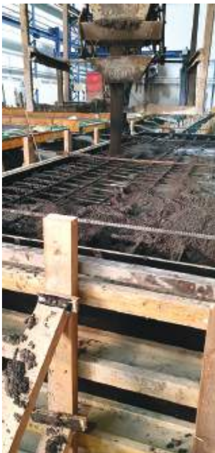
Nehézbeton tároló öntése
